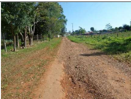
Figura 88: Vista da Estrada Geral do Cará-Cará, sentido bairro – centro. Autor: Orbienge, 2024.
