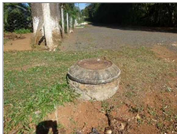
Figura 78: Poço de visita localizado em frente ao empreendimento. Autor: Orbieng, 2024.
