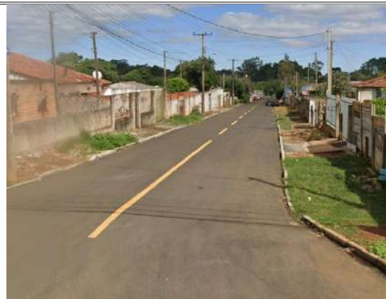
Figura 93: Vista parcial da Rua Peri, sentido empreendimento. Autor: Orbienge, 2024.
