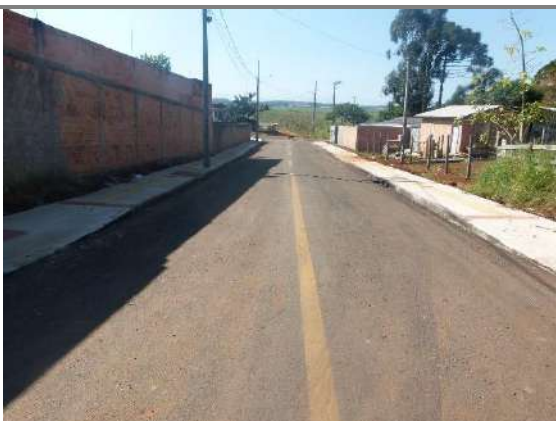
Figura 90: Vista parcial da Rua Cedrilho, sentido terreno do empreendimento. Autor: Orbienge, 2024.
