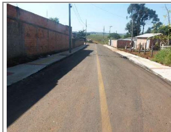
Figura 85: Vista parcial da Rua Cedrilho. Autor: Orbienge, 2024.
