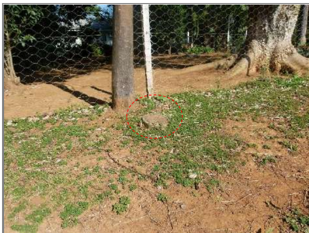
Figura 79: Poço de visita localizado em frente ao empreendimento. Autor: Orbienge, 2024.
