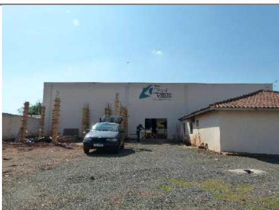
Figura 53: Equipamento comunitário – igreja localizada na Rua Pirapó. Autor: Orbienge, 2024.
