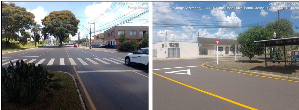
Figura 18 - Condições do pavimento no entorno do empreendimento.
