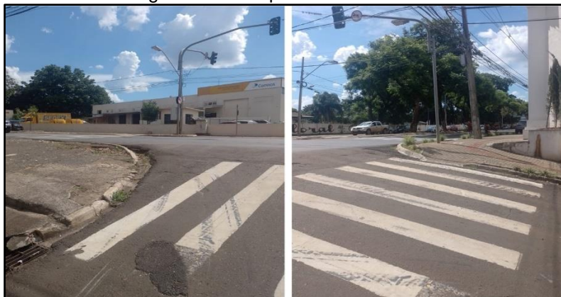
Figura 19 - Rampa de acessibilidade
