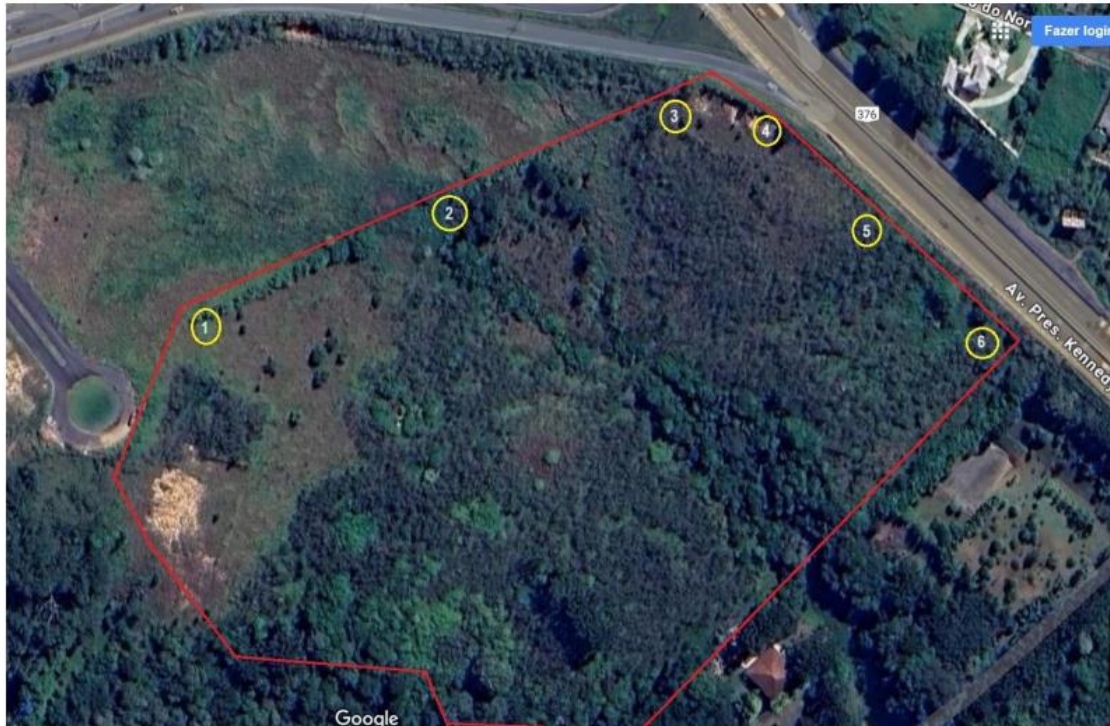
Figura 48: Pontos de medição de ruídos realizados no terreno do empreendimento. FONTE: Laudo de Ruídos.
