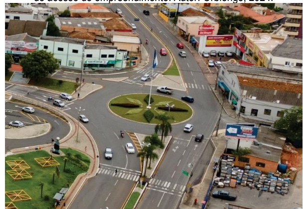
Figura 102: Vista aérea da Rotatória da Rodoviária. Autor: Orbienge, 2022.
