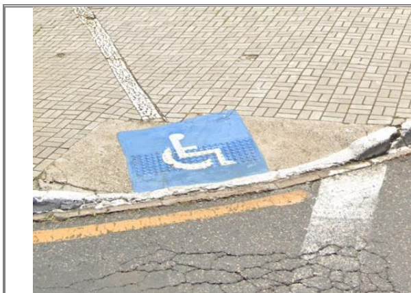
Figura 116: Rampa de acessibilidade na esquina do empreendimento no acesso da Rodoviária. Fonte: Google Street View, 2022.
