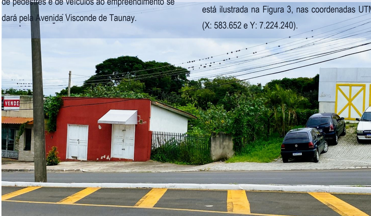
Figura 1: Vista frontal do local de inserção do empreendimento. Autor: Orbienge 2024.
