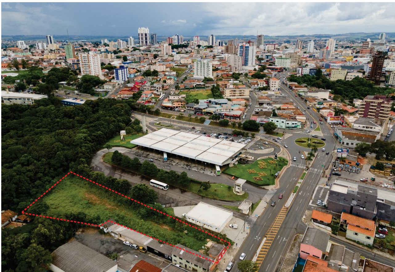
Figura 2: Vista aérea da área de implantação do futuro empreendimento (destacar a área do empreendimento) Autor: Orbienge, 2022.
