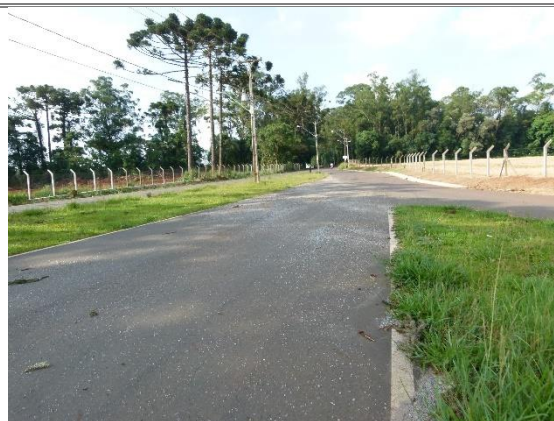
Figura 89: Distribuição de energia e iluminação na Avenida Pedro Wosgrau. Autor: Orbienge, 2023.
