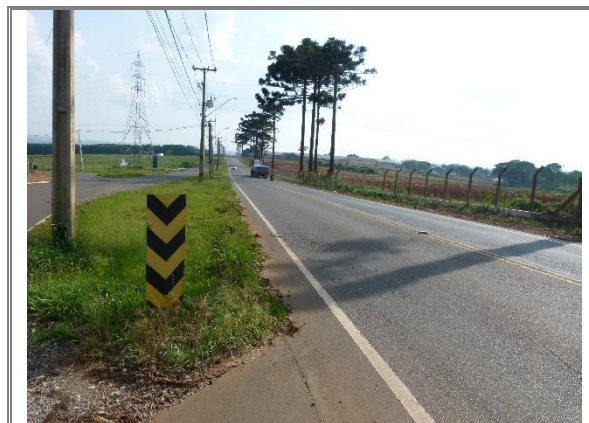
Figura 104: Vista da Avenida Pedro Wosgrau, sentido bairro Uvaranas – Rodovia BR 376. Autor: Orbienge, 2023.
