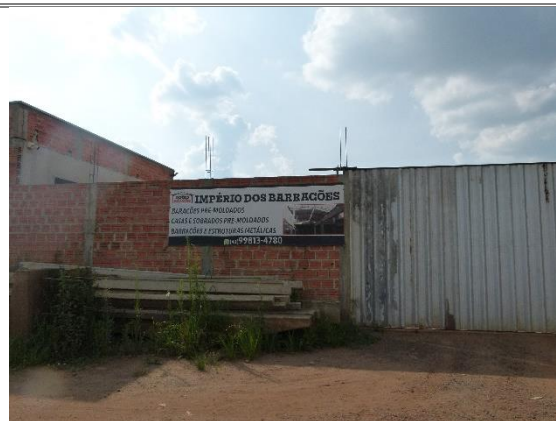
Figura 44: Atividade de serviços – montagem de estruturas metálicas e barracões localizado na Avenida Pedro Wosgrau. Autor: Orbiengue, 2023.
