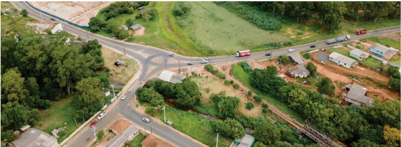
Figura 9: Vista aérea da rotatória Leandro Zambrzycki Petlak e das vias de interseção. Autor: Orbieng, 2022.
