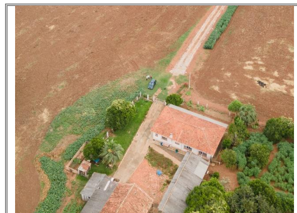
Figura 4: Vista aérea da edificação existente no terreno do empreendimento. Autor: Orbieng, 2022.
