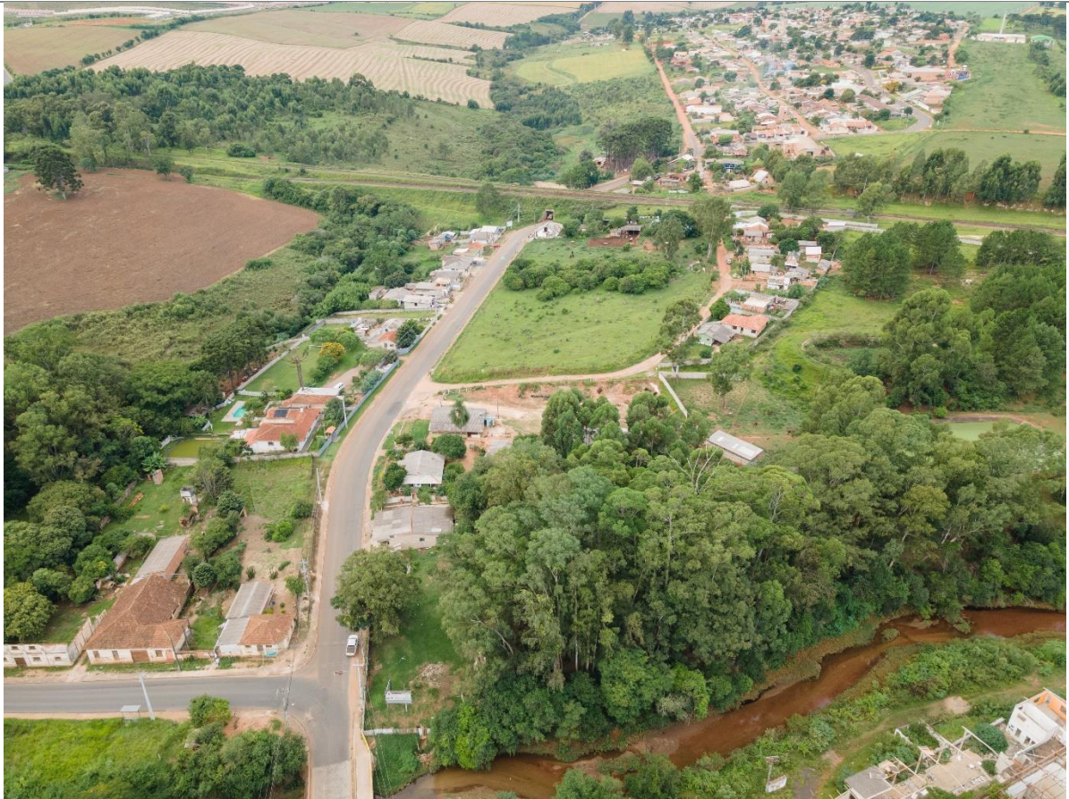
Figura 49: Vista aérea do entorno do empreendimento. Autor: Orbieng, 2022.
