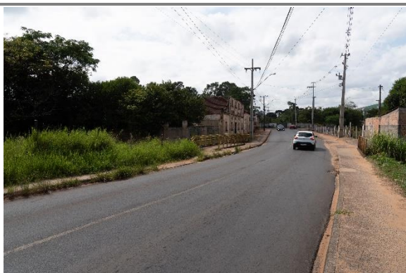
Figura 75: Vista da Estrada Sebastião Bastos sentido bairro – centro. Autor: Orbiengge, 2024.
