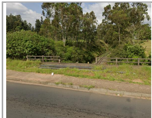
Figura 51: Tubulação da rede de água e esgoto junto à Estrada Sebastião Bastos. Fonte: Google Street View, 2023.
