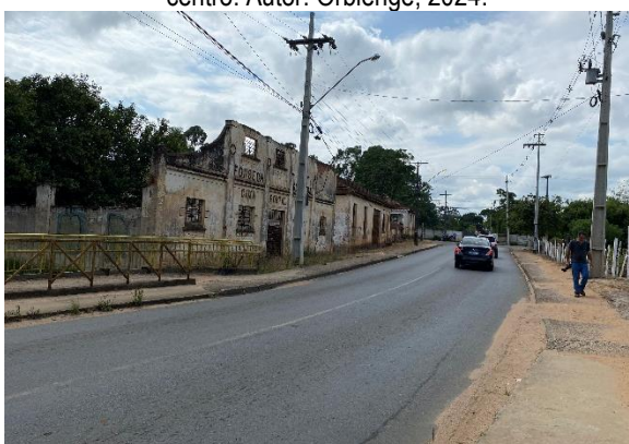
Figura 76: Vista da Estrada Sebastião Bastos sentido bairro – centro. Autor: Orbiengge, 2024.
