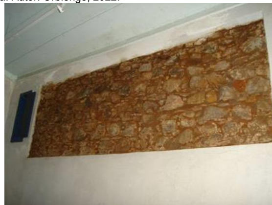
Figura 44: Vista interna da Capela Santa Bárbara. Autor desconhecido, s/d.
