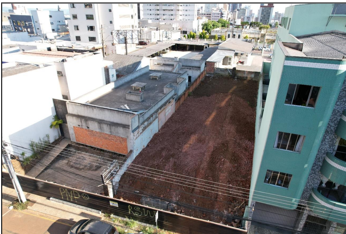
Imagem 04: Visão geral da área de instalação do edifício.
