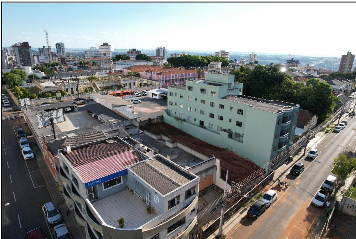
Imagem 03: Visão geral da área de instalação do edifício.
