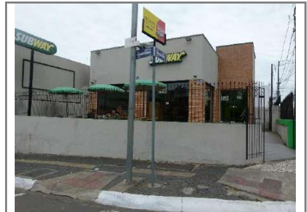
Figura 139: Vista da esquina da Rua Balduino Taques com a Rua Julia Wanderley. Autor: Orbienge, 2023.
