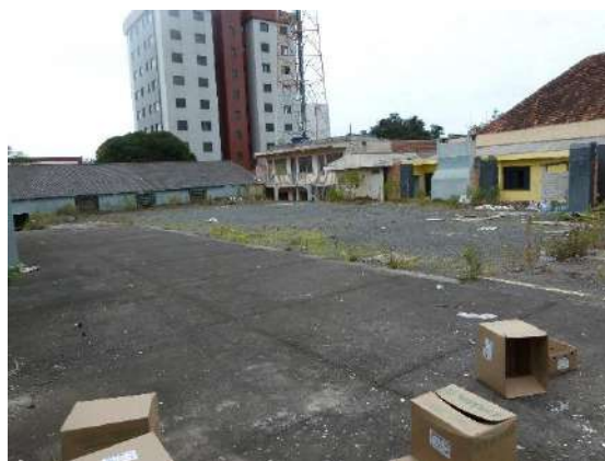
Figura 5: Edificações existentes no lote de implantação do empreendimento. Autor: ORBIENGE, 2023.
