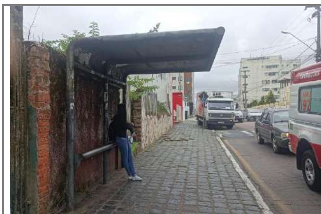
Figura 133: Ponto de ônibus localizado na Rua Barão de Cerro Azul, no sentido centro-bairro. Autor: ORBIENGE, 2023.
