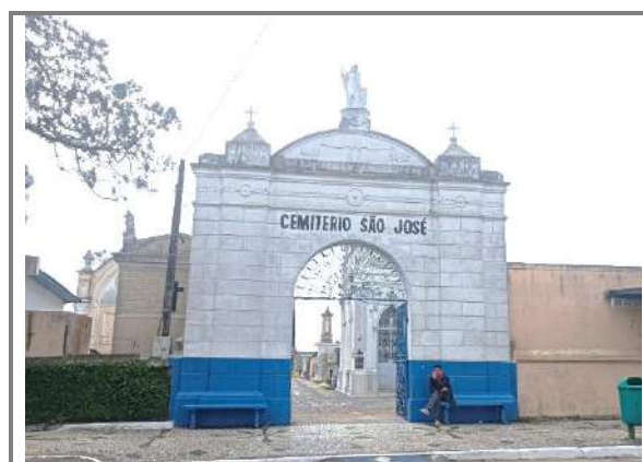
Figura 73: Portal de entrada do Cemitério São José. Autor: ORBIENGE, 2023.
