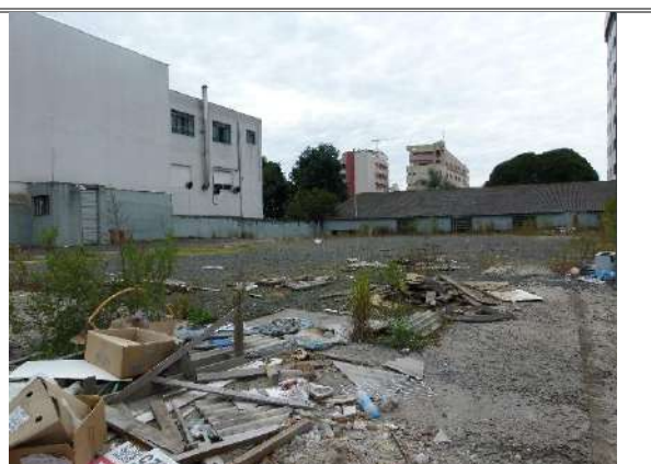
Figura 3: Edificações existentes no lote de implantação do empreendimento. Autor: ORBIENGE, 2023.
