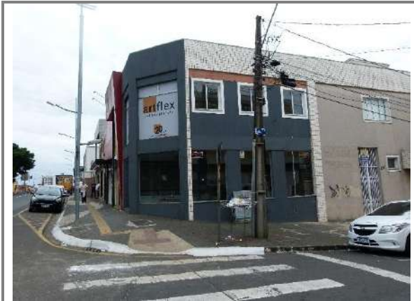
Figura 136: Vista da rampa de acessibilidade na esquina da Rua Balduino Taques com a Rua Tiradentes. Autor: ORBIENGE, 2023.
