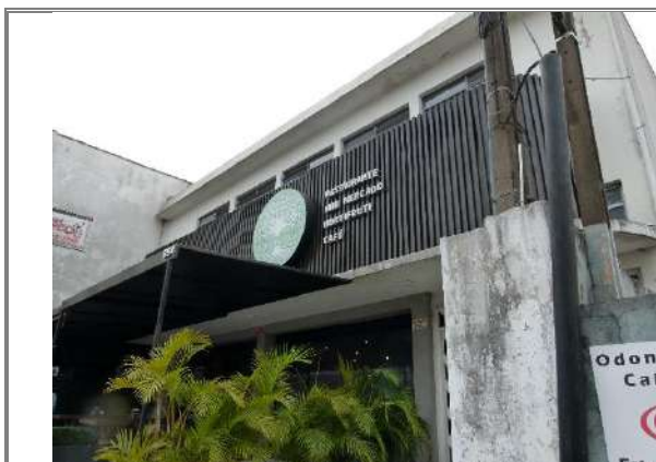
Figura 2: Edificações existentes no lote de implantação do empreendimento. Autor: ORBIENGE, 2023.
