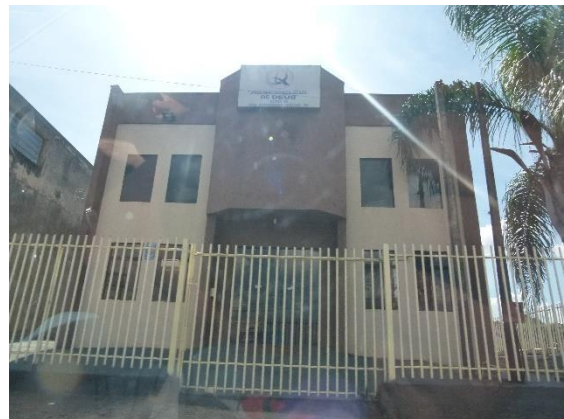
Figura 42: Equipamento comunitário – igreja, localizada na Avenida Tocantins. Autor: ORBIENGE, 2023.
