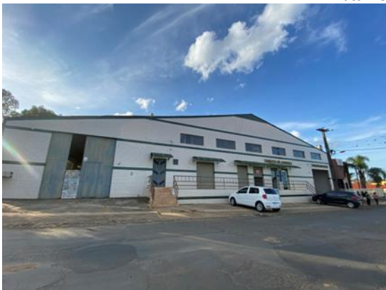
Figura 23: Atividade de comércio – farmácia, localizado na Avenida Tocantins. Autor: ORBIENGE, 2023.
