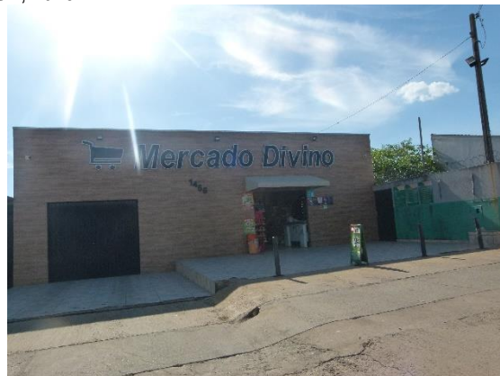
Figura 24: Atividade de comércio – mercado, localizado na Avenida Tocantins. Autor: ORBIENGE, 2023.
