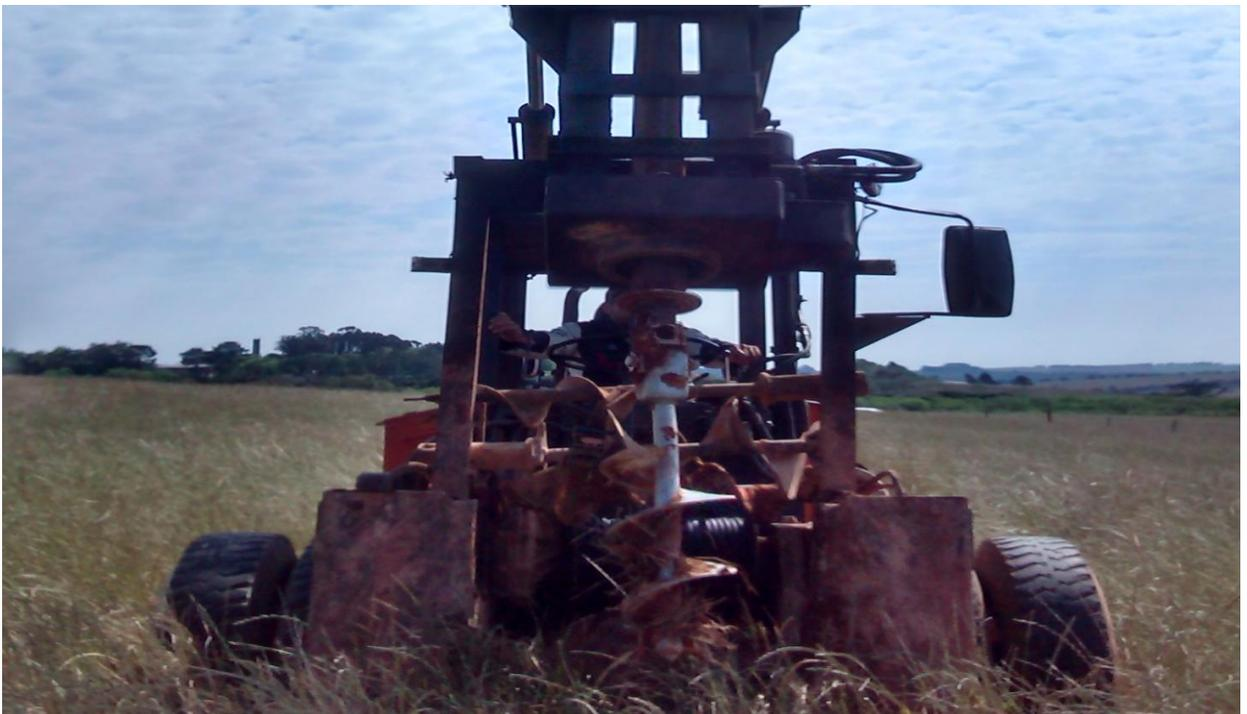
**INICIO DO SEGUNDO FURO DE SONDAAGEM PARA IDENTIFICAÇÃO DO LENÇOL FREÁTICO**
