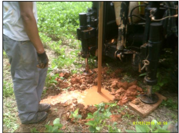
Sondagem SR05 – atingindo nível freático
