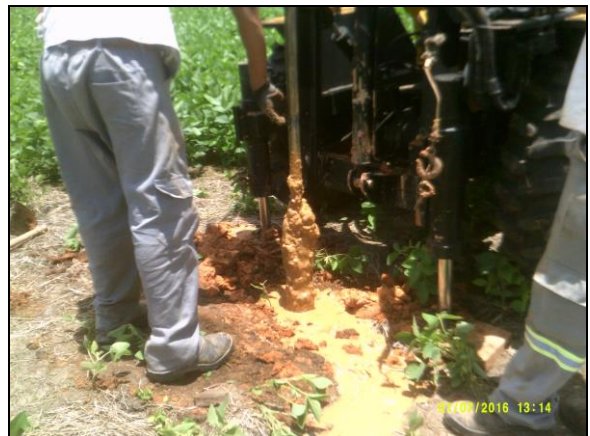
Sondagem SR08 – atingindo nível freático
