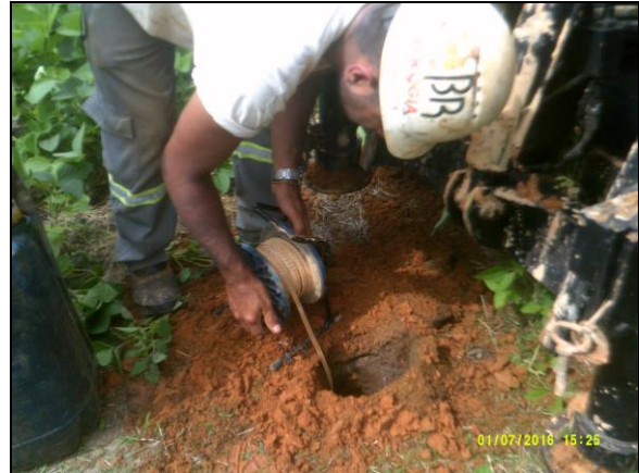
Momento da medição da variação dos níveis de água utilizando medidor de nível eletrônico
