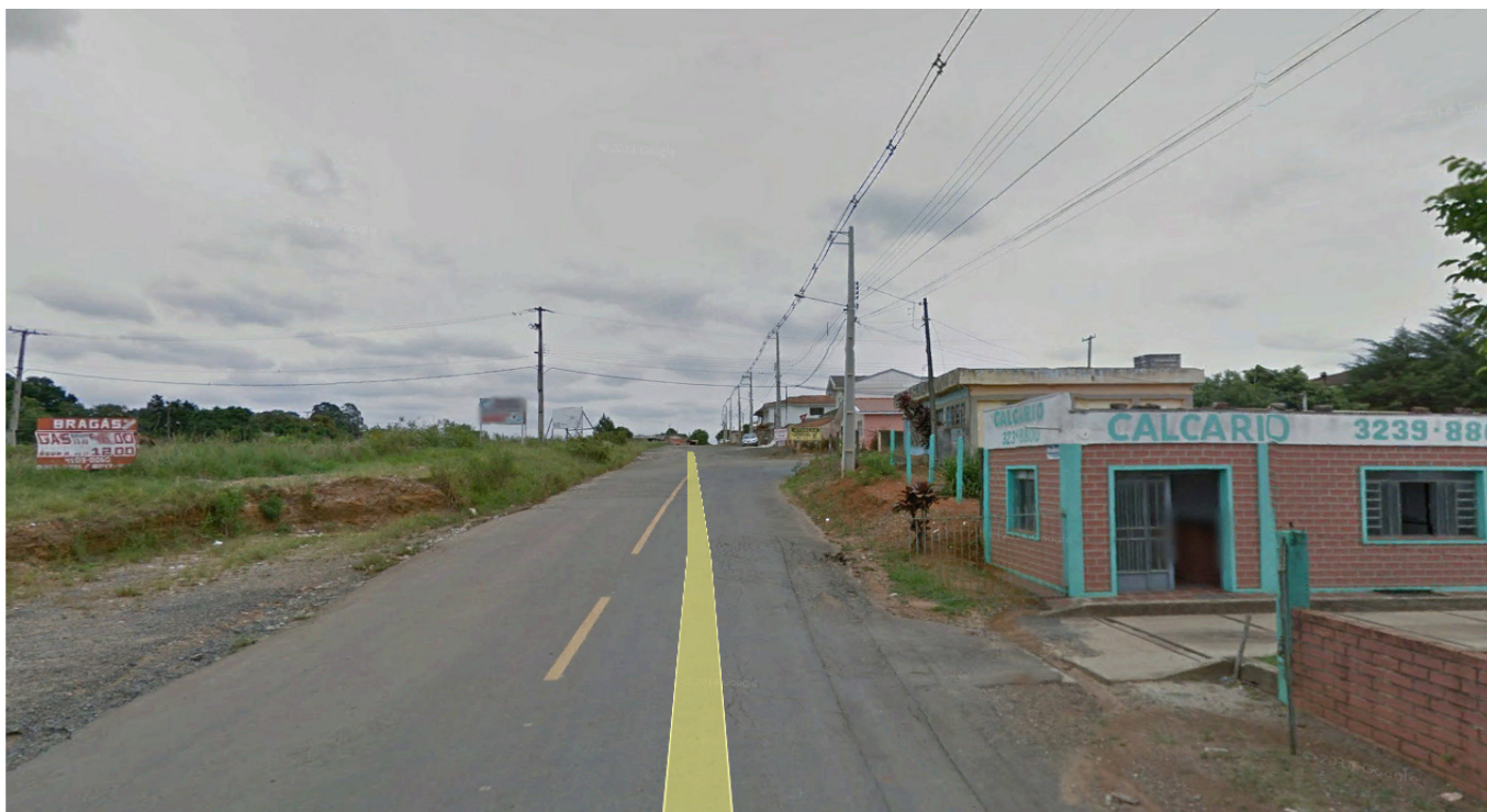
Figura 25: Ponto E - Rua Sabiá Fonte: Google Earth (2017)
