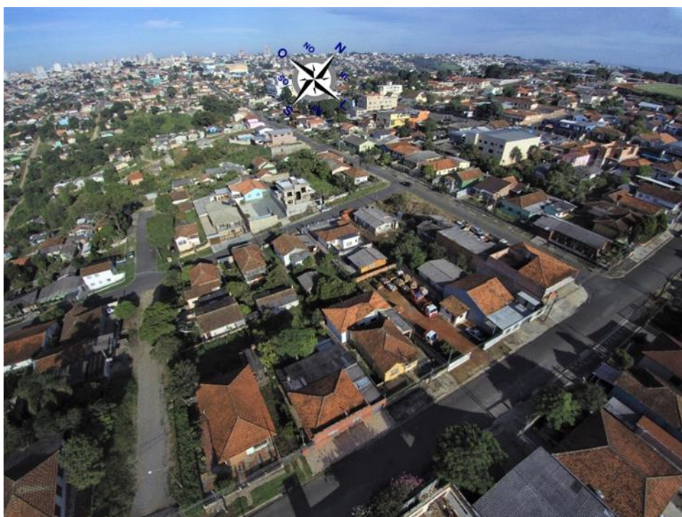
Figura 39- Vista do Empreendimento ao lado Noroeste. Fonte: Dado coletado em campo.
