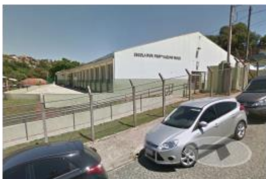
Figura 55 – Escola Municipal Kazuko Inoue
