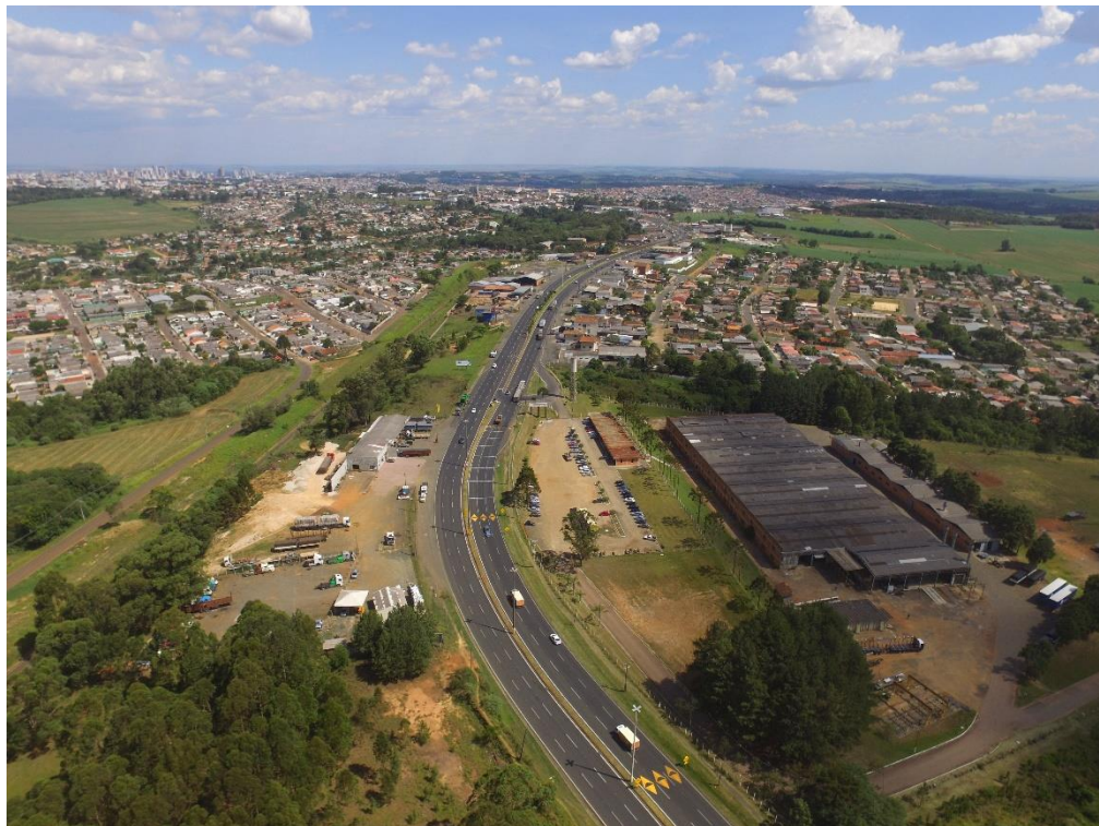
Figura 14 - Imagem aérea da Av. Souza Naves próximo ao empreendimento. Fonte: Autor (2018).
