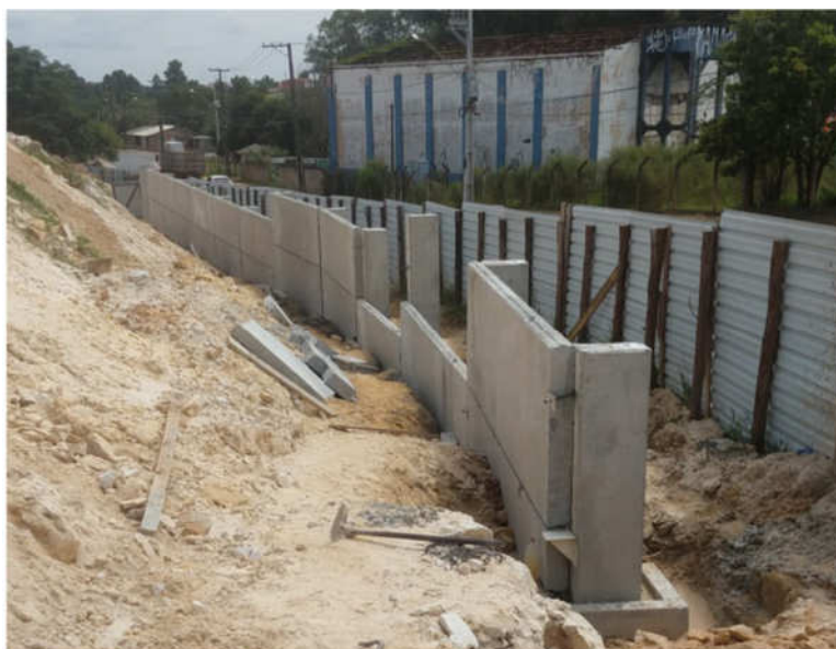
Foto 01: Muro alinhamento predial – Março/2021
