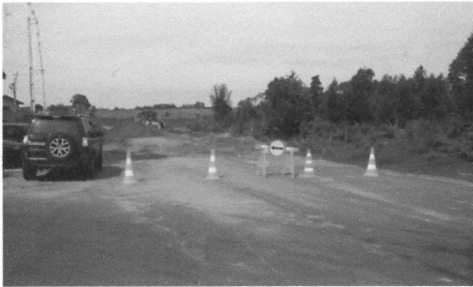
Figura 4A Obras da avenida
