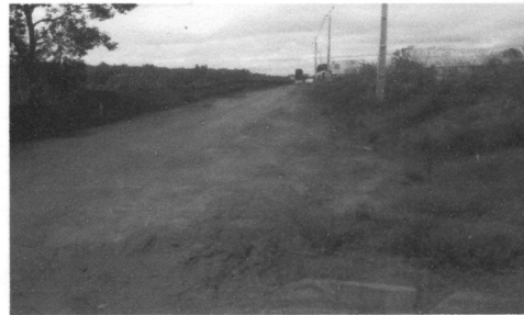
Figura 4D Obras da avenida
