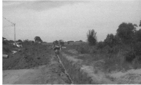
Figura 4B Obras da avenida
