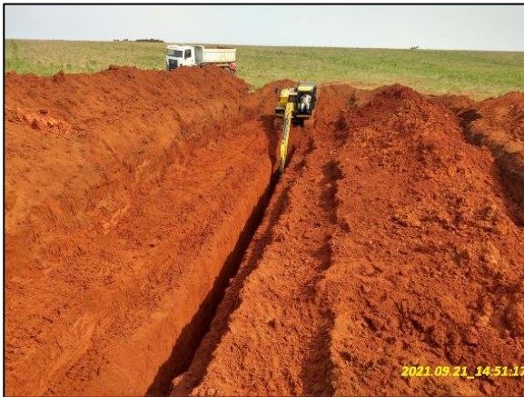
Escavação das trincheiras de inspeção – TR2
