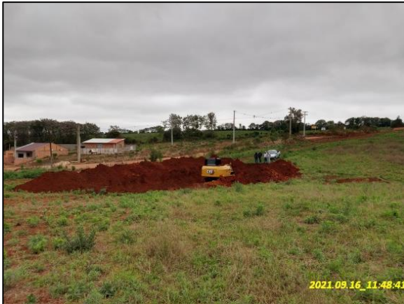
Escavação das trincheiras de inspeção – TR1
