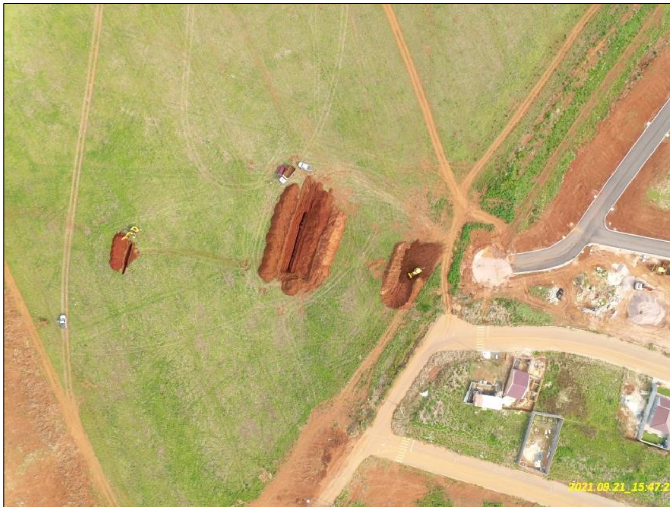
Vista da área das trincheiras de inspeção
