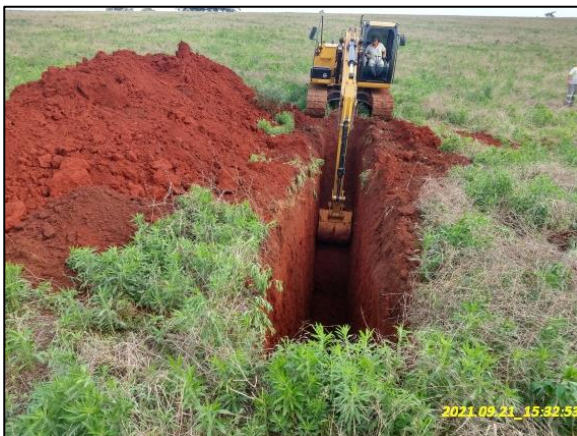
Escavação das trincheiras de inspeção – TR3
