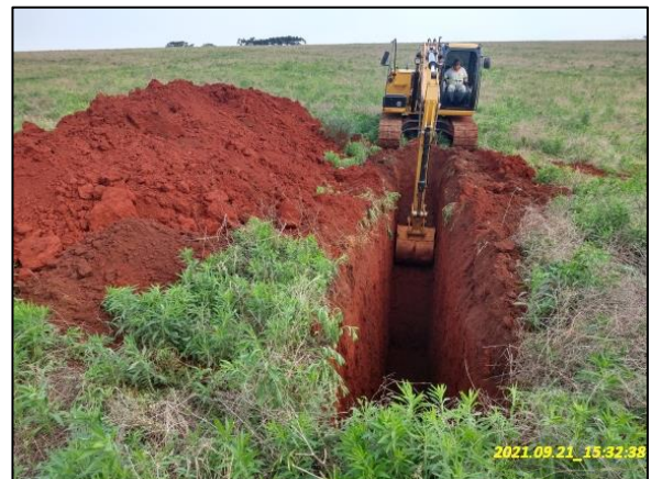
Escavação das trincheiras de inspeção – TR3
