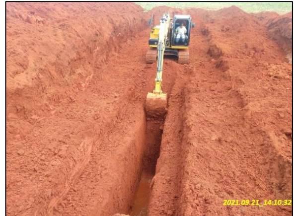
Escavação das trincheiras de inspeção – TR2
