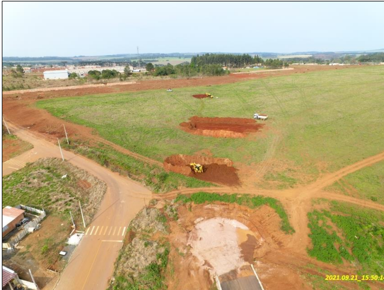
Disposição das trincheiras de inspeção ao longo do talvegue – vista para montante
