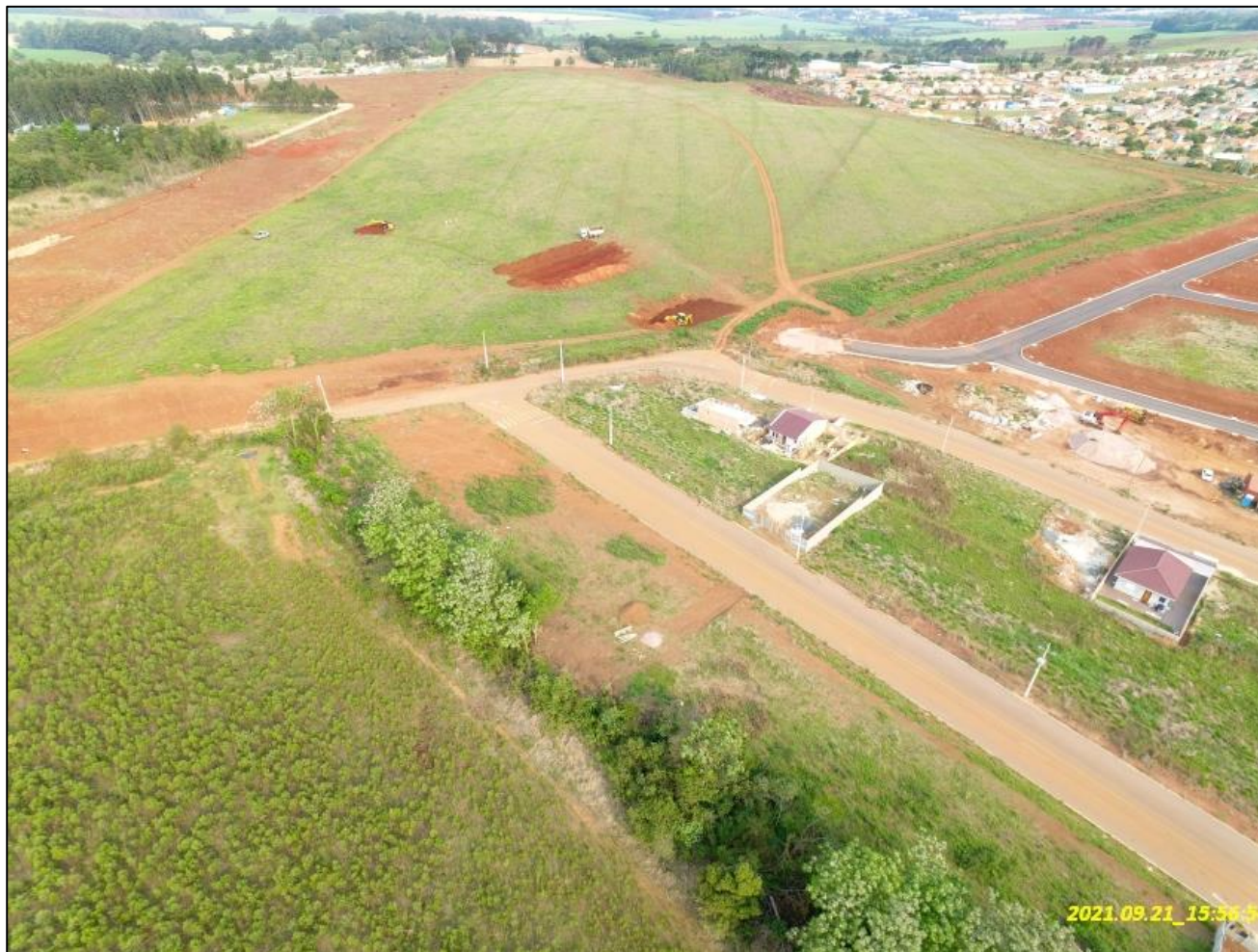
Disposição das trincheiras de inspeção ao longo do talvegue – vista para montante com destaque para toda área do empreendimento
