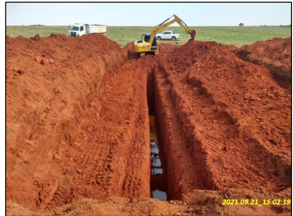
Escavação das trincheiras de inspeção – TR2
