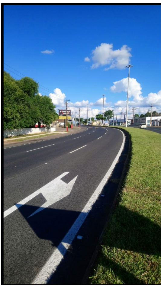
Figura 59: Sinalização Viária direcional – Piso Fonte: A Autora, 2018.
