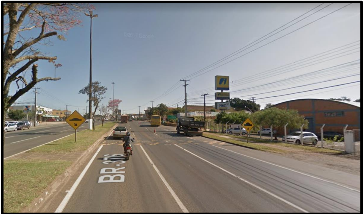
Figura 60: Redutor de velocidade
