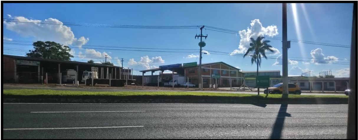
Figura 48: Ponto 2 - Levantamento do Entorno - Equipamentos Hidráulicos Fonte: A Autora, 2018
