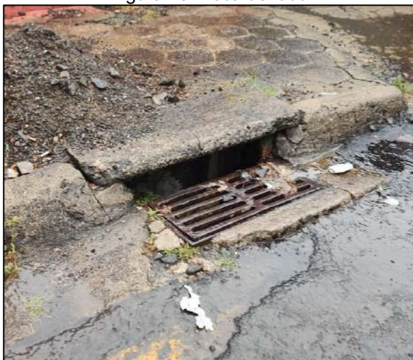
Figura 45. Boca de lobo.
