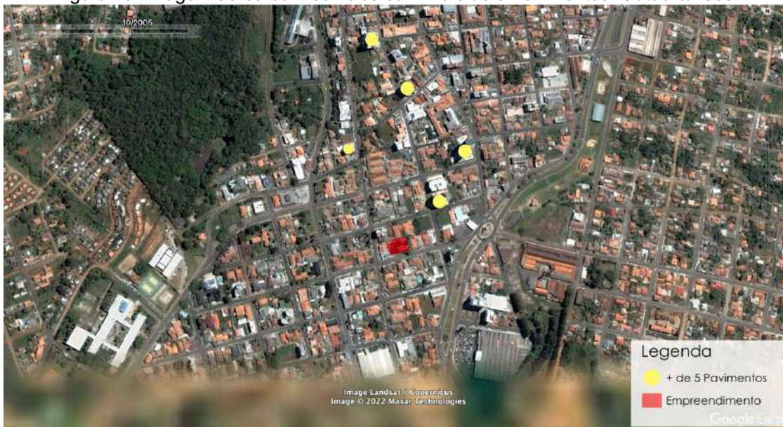
Figura 20. Imagem aérea com edifícios com mais de 5 Pavimentos. Outubro/2005.
