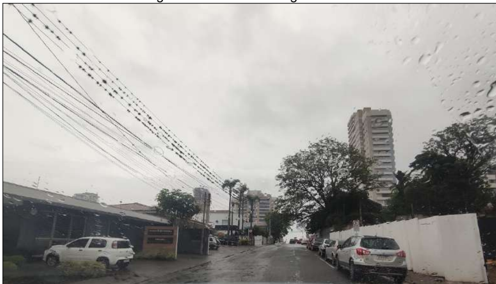
Figura 47. Rede de energia elétrica.
