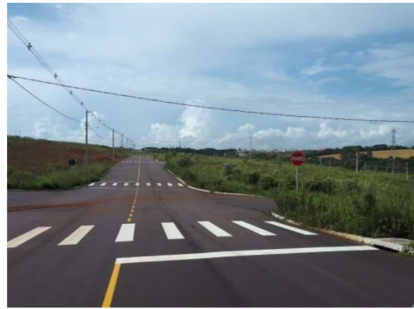
Foto 12 - Faixas de pedestre e placa de 'PARE'.
