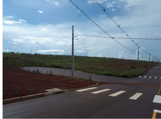
Foto 6 – Boca de leão próximo ao empreendimento.
