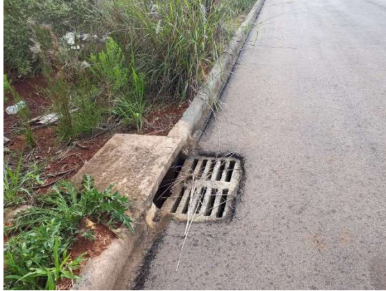
Foto 5 – Boca de lobo próximo ao empreendimento.
