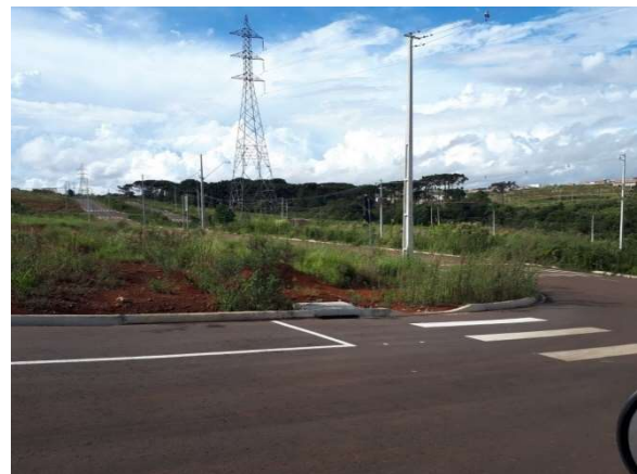
Foto 14 - Local permitido para o estacionamento de veículos.
