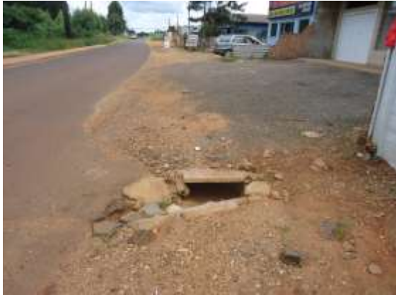
Foto 2 – Rua Siqueira Campos, em frente ao futuro empreendimento.
