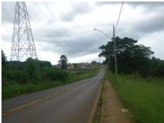
Foto 4 – A Rua Vinte possui calçamento somente no sentido norte.
