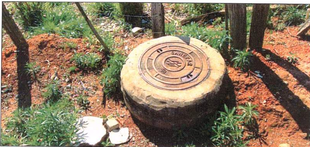
Fotografia 09: Caixa de passagem de tubulação subterrânea que cruza o terreno examinado.
