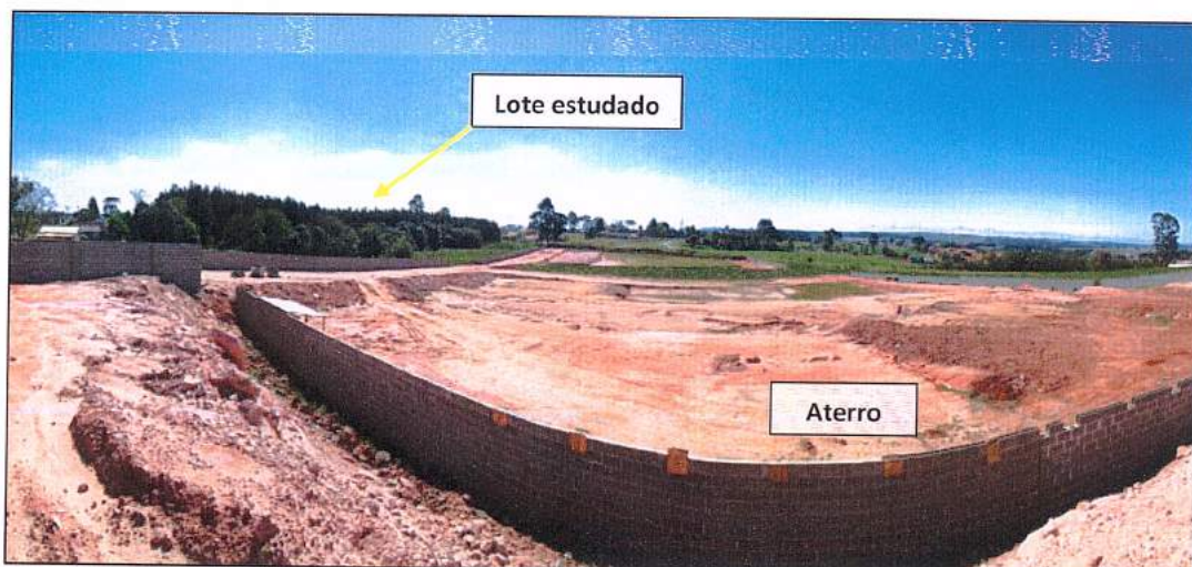
Fotografia 11: Vasto terreno aterrado à jusante do lote avaliado.
