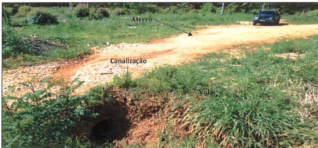
Fotografia 07: Canalização e valas no interior do lote.
