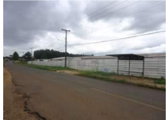
Foto 3 - A Rua Siqueira Campos não possui calçada apropriada para pedestres em alguns trechos.
