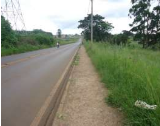
Foto 9 – Via sem sinalização.
