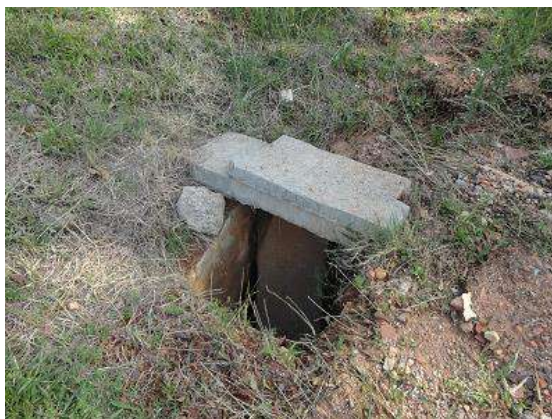
Foto 16 – Boca de lobo na via
