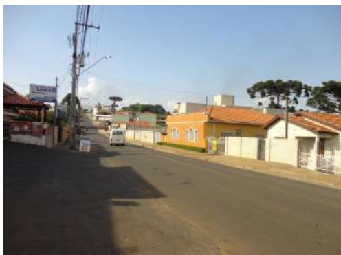
Foto 20 - Rua Siqueira Campos, trecho asfaltado e com calçamento.
