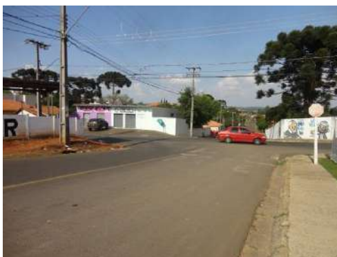
Foto 22 - Placa de 'Pare' identificada na Rua Dolarício Correia, esquina com a Rua Siqueira Campos.
