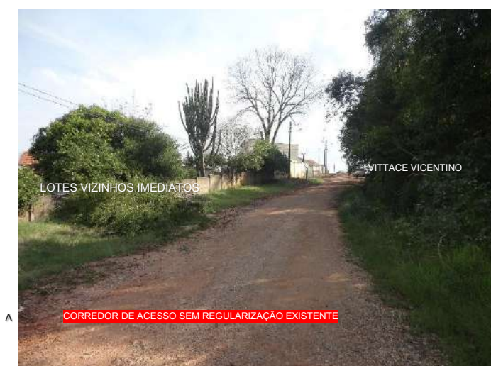
Figura 10 – Foto do corredor de acesso sem regularização existente. Fonte: Levantamento in loco (2017)
