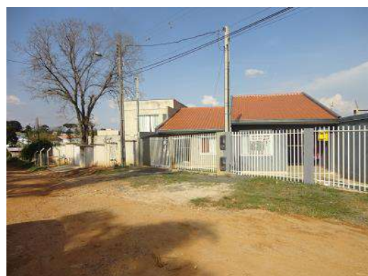
Foto 11 – Residências na Rua Barbosa Ribeiro
