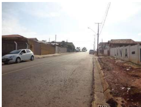
Foto 21 - Rua Dolarício Correia, trecho asfaltado, com sarjeta e galeria de drenagem.
