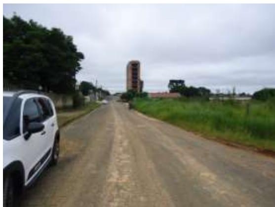
Foto 19 - Ausência de rede de micro drenagem em frente ao empreendimento.
