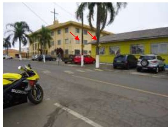
Foto 27 – Sinalização de lombada e pedestre na Av. Melvin Jones.
