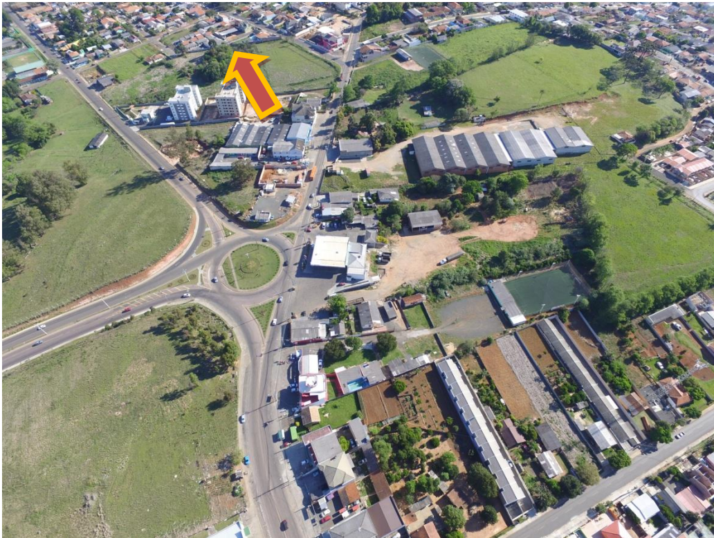
Figura 45- Vista do Empreendimento ao lado Sudoeste.
