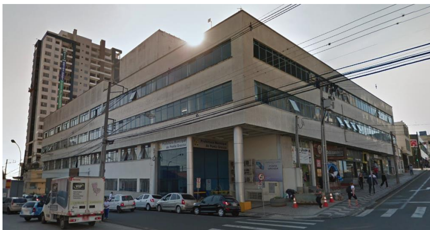
Figura 27: Edifício Guaíra - serviços prestados na região de entorno do empreendimento.
