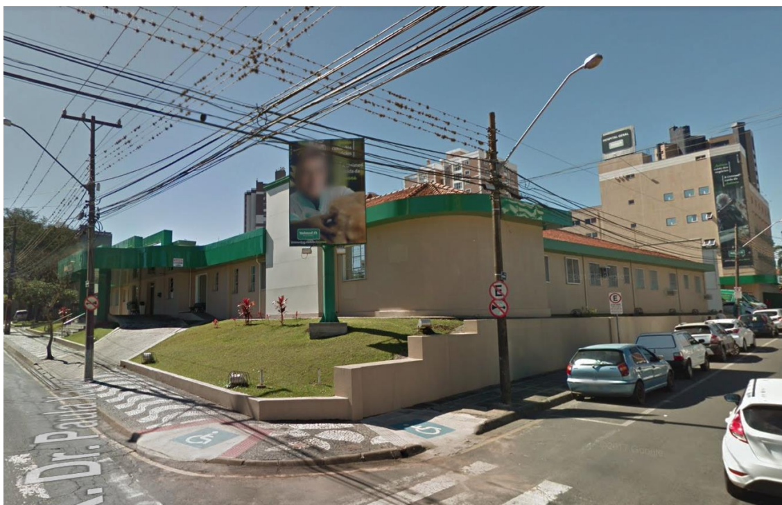
Figura 56: Acessibilidade implantada na calçada de acesso ao empreendimento.
