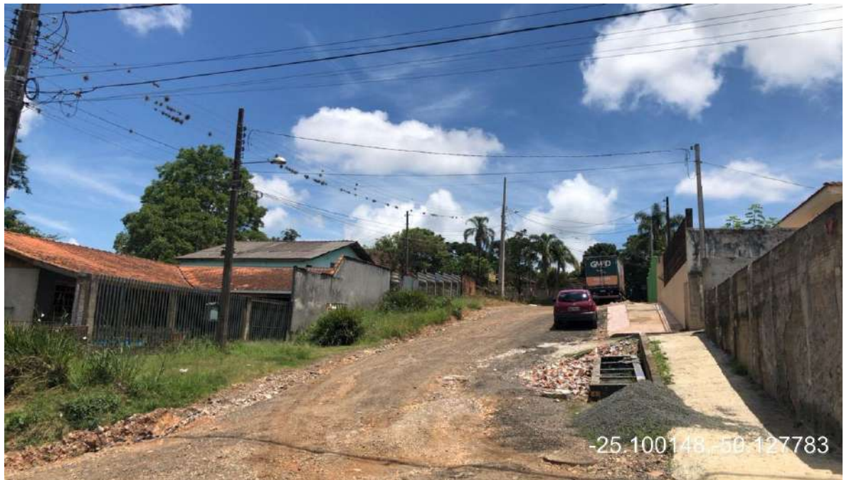
Figura 32 – Condição do asfaltamento na Rua Barbosa Rodrigues.
