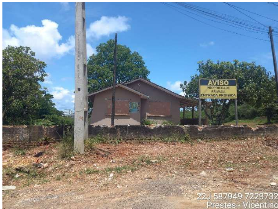
Figura 4 - Vista da frente do terreno de instalação do empreendimento.
