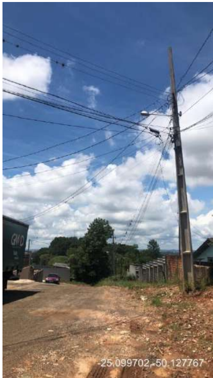
Figura 30 - Condição de pavimentação.
