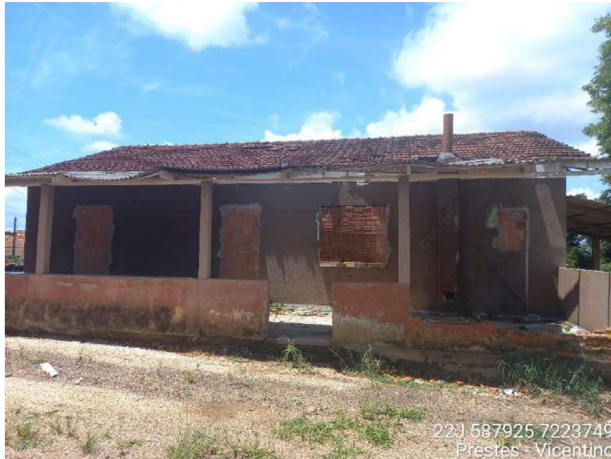
Figura 7 - Vista da construção presente no terreno de instalação do empreendimento.
