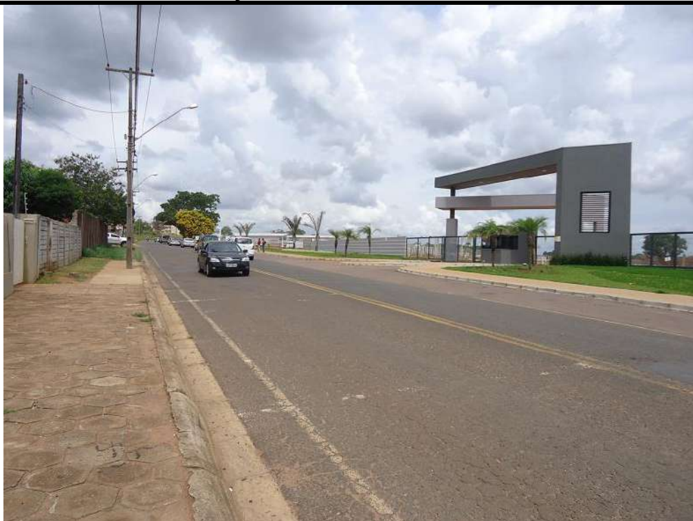
Foto 4 – Rua Valério Ronchi com calçamento, em frente ao empreendimento em estudo.
