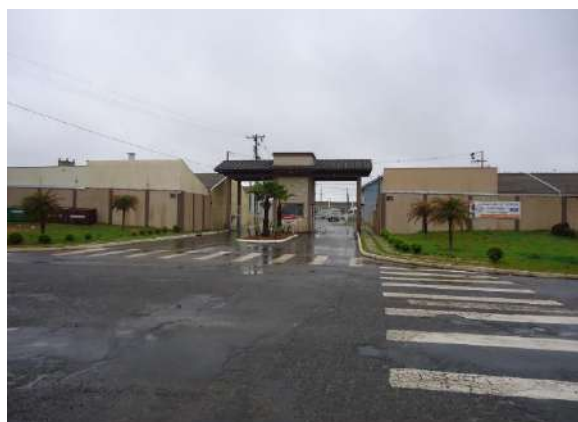
Foto 13 – Conjunto habitacional localizado na Rua Valério Ronchi.
