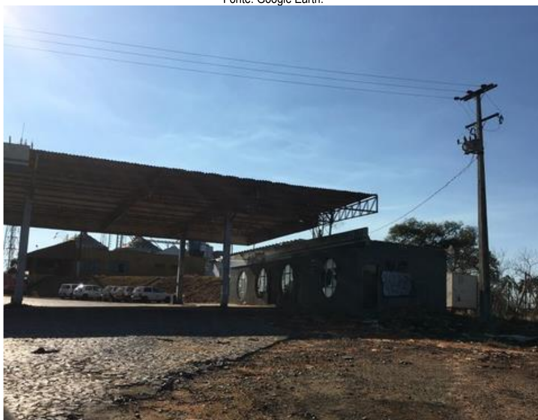
Figura 34: Vista da cobertura e conveniência do antigo posto de combustível. Fonte: Proprietário do imóvel.
