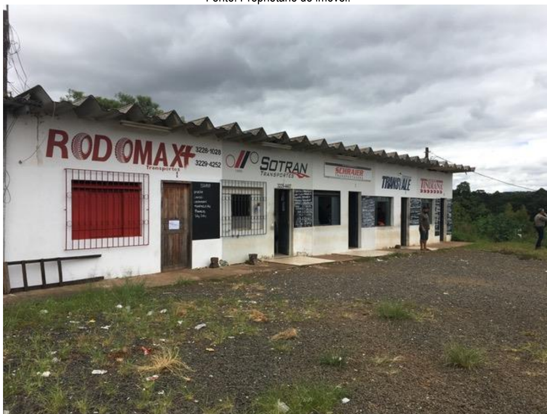
Figura 36: Vista das edificações existentes. Fonte: Proprietário do imóvel.
