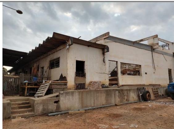
Figura 5: Edificação existente a ser demolida.
