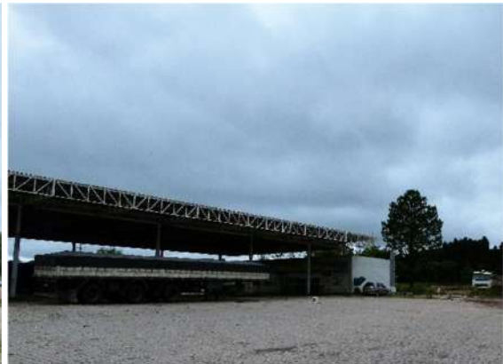
Figura 18: Posto - Vista cobertura.
