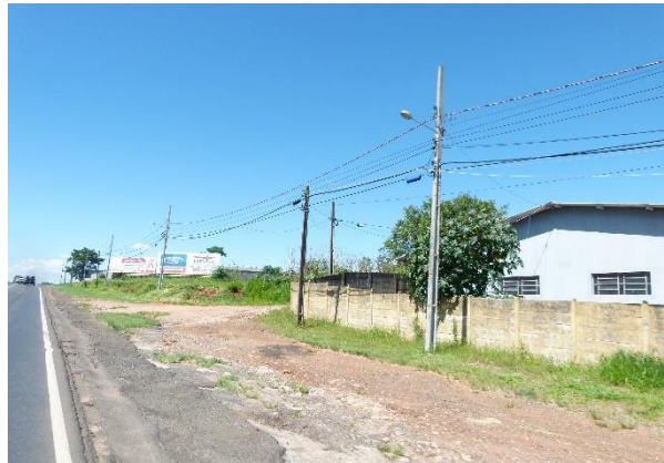
Figura 6: Vista parcial da área de inserção e edificação vizinha. Fonte: Acervo Orbienge.
