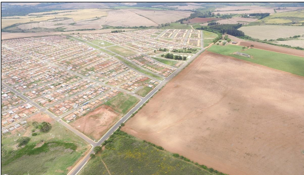
Figura 39 – Vista do empreendimento ao lado Norte. Fonte: Dados coletados em campo.
