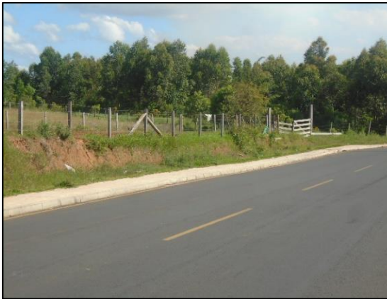
Figura 16 – Vista para o local do futuro empreendimento.
