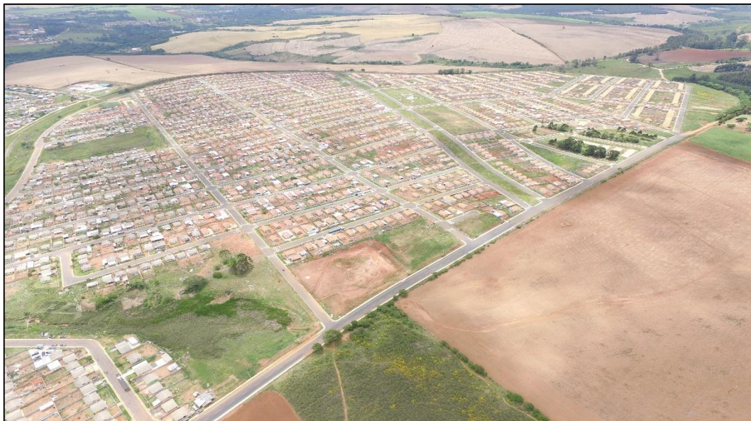
Figura 46 – Vista do empreendimento ao lado Noroeste. Fonte: Dados coletados em campo.
