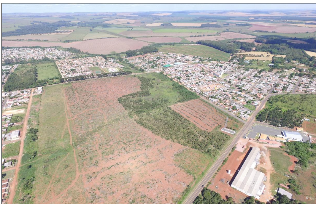
Figura 43 – Vista do empreendimento ao lado Sudeste. Fonte: Dados coletados em campo.
