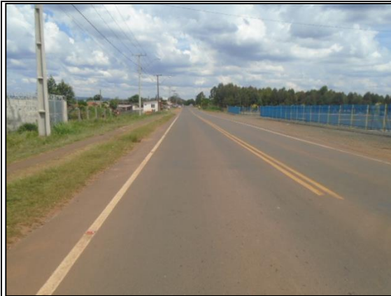
Figura 09 – Vista para Rua Siqueira Campos – Avenida Pedro Wosgrau – sentido BR-376.
