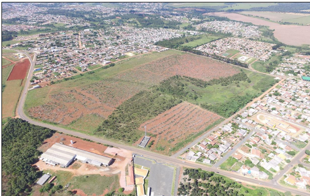
Figura 41 – Vista do empreendimento ao lado Nordeste. Fonte: Dados coletados em campo.
