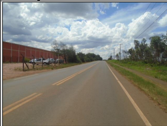
Figura 11 – Vista para Rua Siqueira Campos sentido Bairro Uvaranas.
