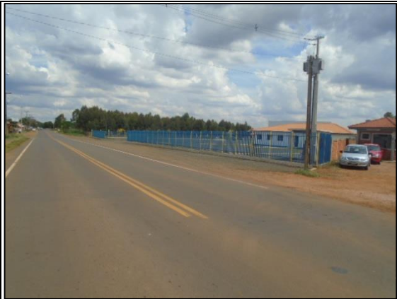
Figura 10 – Vista para Rua Siqueira Campos – Avenida Pedro Wosgrau – sentido BR-376.
