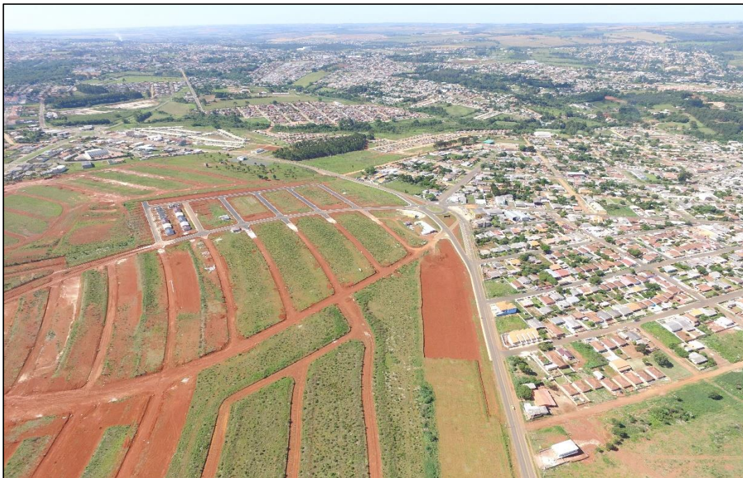
Figura 47 – Vista do empreendimento ao lado Noroeste. Fonte: Dados coletados em campo.
