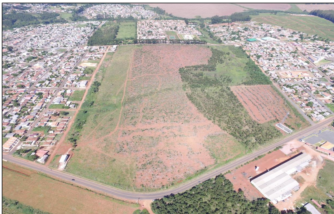
Figura 42 – Vista do empreendimento ao lado Leste. Fonte: Dados coletados em campo.
