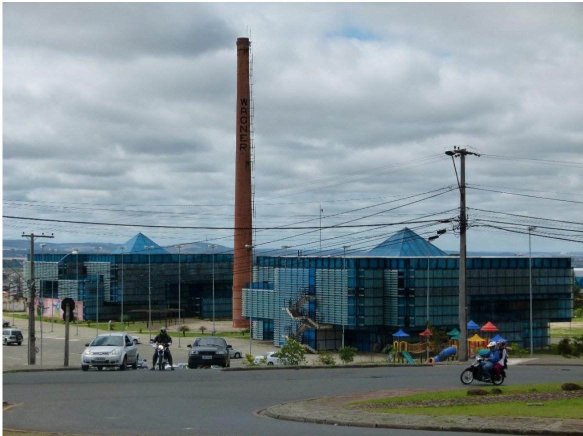
Figura 42: Chaminé Wagner, remanescente das Indústrias Wagner.
