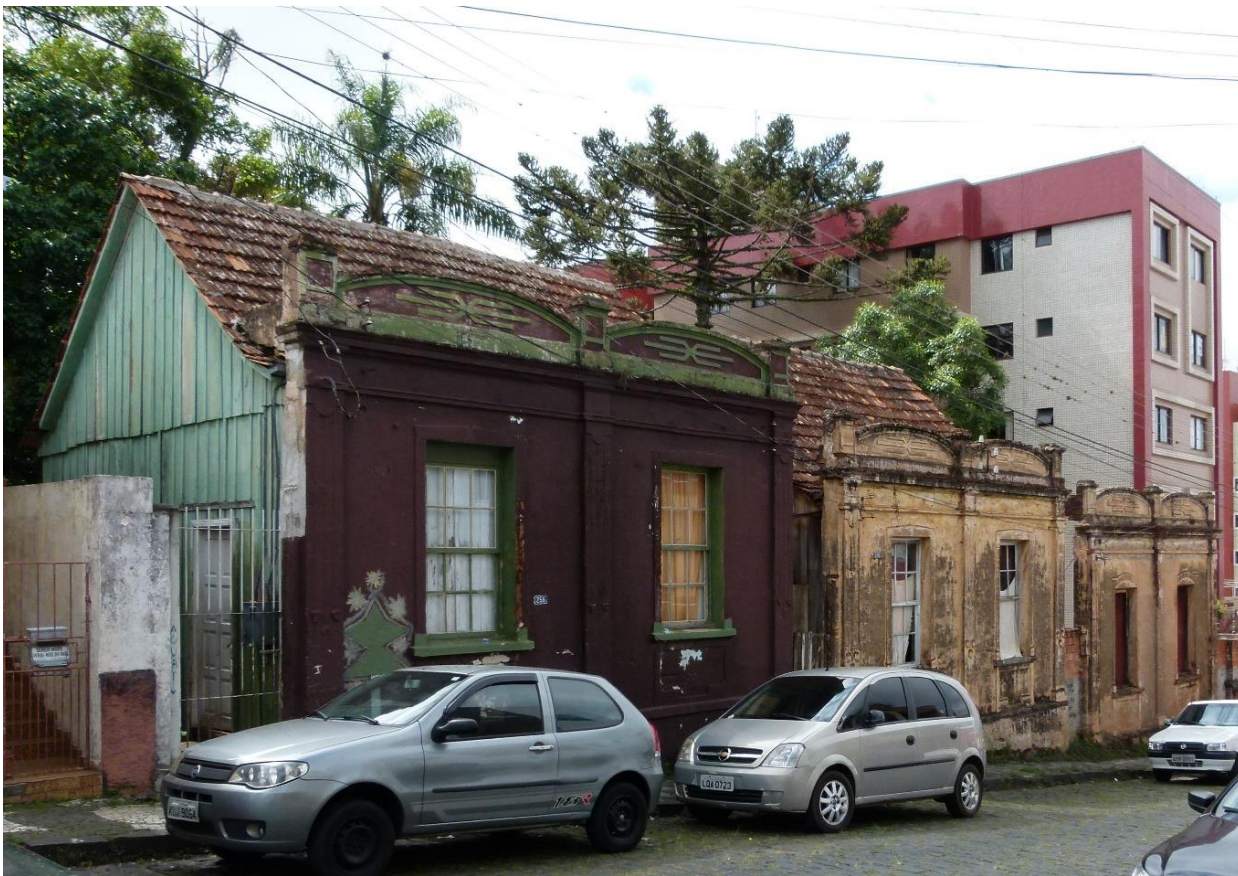
Figura 45: Residência das Irmãs Bokla.
