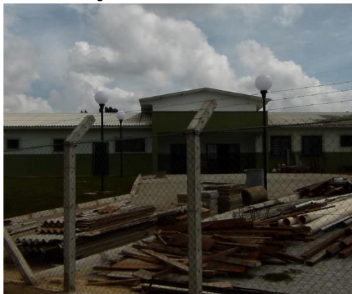
Figura 62: Esc. Municipal em Construção (Ouro Verde)
