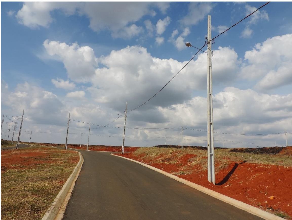
Figura 63: Situação da Rua Moacir Bacovis que dá acesso as vias do empreendimento.
