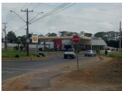
Figura 34: Posto de combustível.
