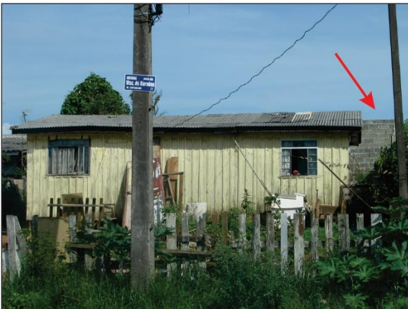
Foto 6: Demonstração da relação do muro da divisa SW com a vizinhança
