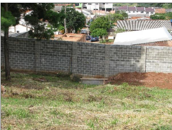
Foto 8: Vista de sistema infiltração de águas pluviais
