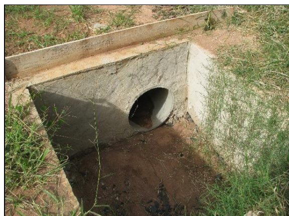
Foto 9: Vista de sistema infiltração de águas pluviais
