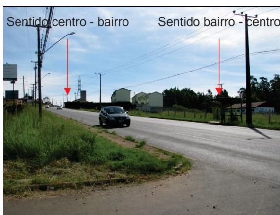
Foto 5: Pontos de ônibus na Avenida Monteiro Lobato nas proximidades do empreendimento
