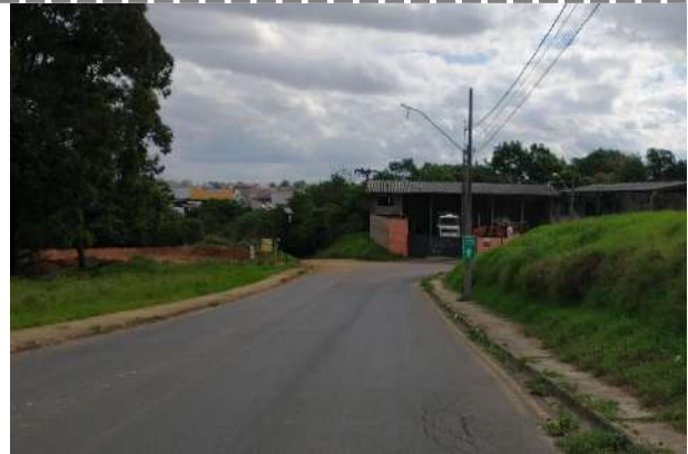
Figura 91: Vista parcial do passeio da Rua Fontoíno Xavier Domingos de Magalhães. Autor: ORBIENGE, 2021.
