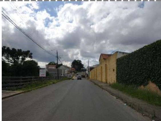
Figura 88: Vista parcial do passeio da Rua Barão de Monte Alegre. Autor: ORBIENGE, 2021.
