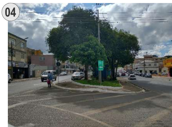
Figura 76: Vista da Avenida Dom Pedro II, acesso a Rua Teixeira de Freitas. Autor: ORBIENGE, 2021.
