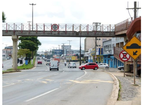
Figura 86: Vista da passarela aloçada a 75 m do local de inserção. Fonte: Orbienge.
