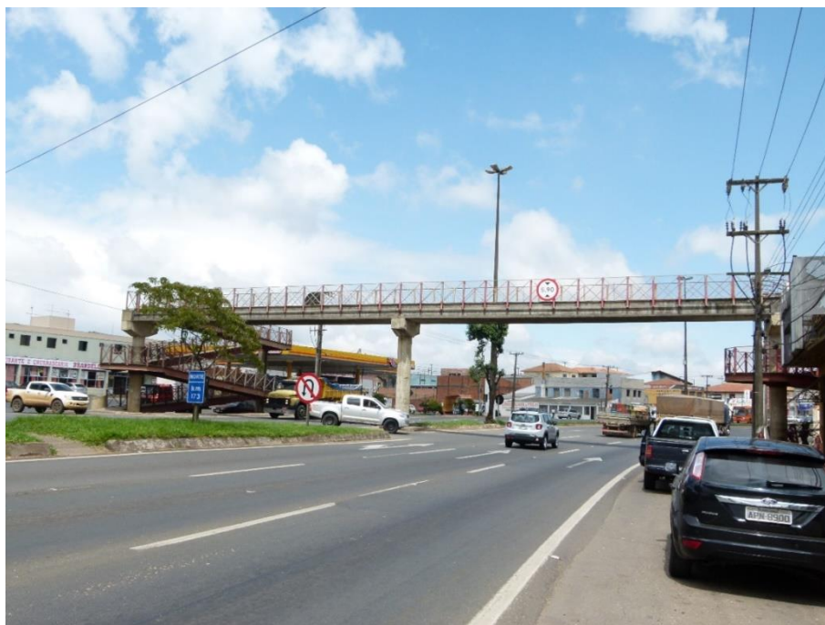
Figura 58: Passarela de travessia localizada na Avenida Souza Naves a 75 m do local de inserção. Fonte: Orbienge.
