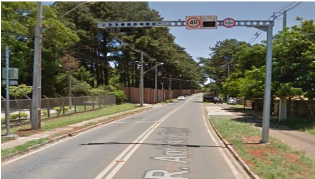
Figura 19 – Redutor de velocidade
