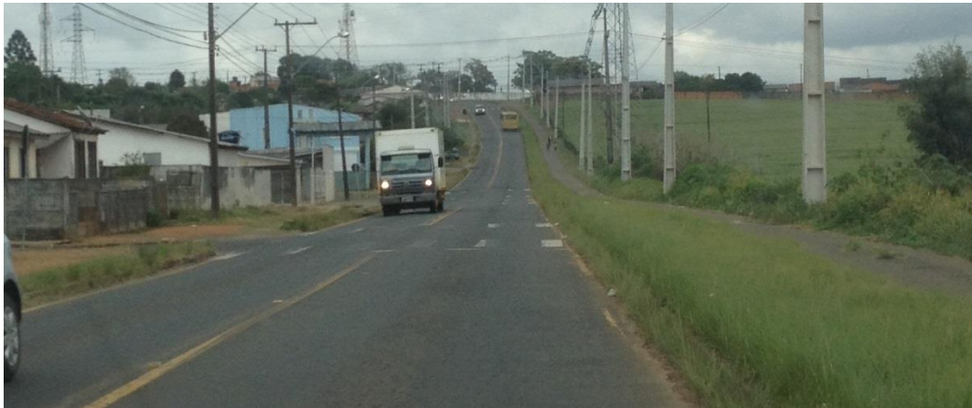
Figura 8 – Avenida Antônio Saad em direção à rodovia
