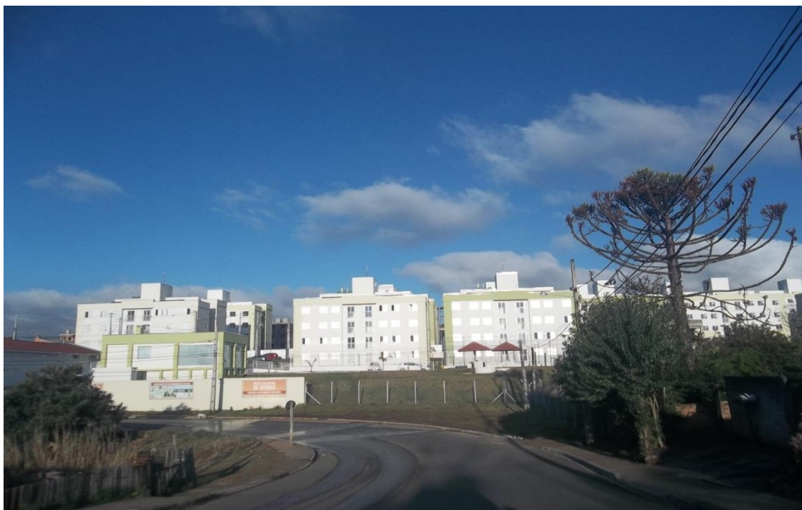
Figura 12: Empreendimento em construção
