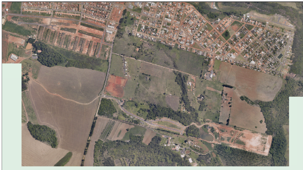
Figura 20 - Entorno da gleba com presença de pipings. Fonte: Geoweb (2021).
