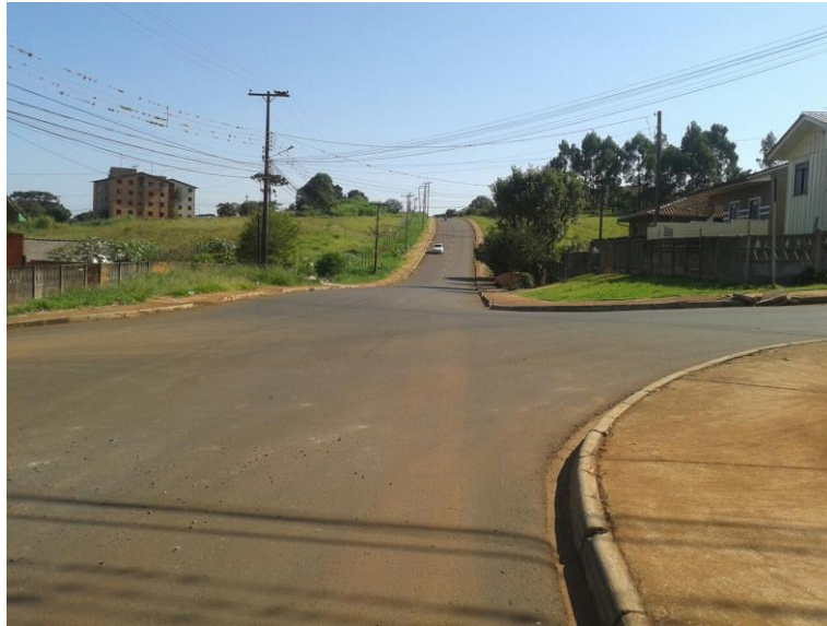
Figura 8: Foto do local, mostrando a vazão urbano.
