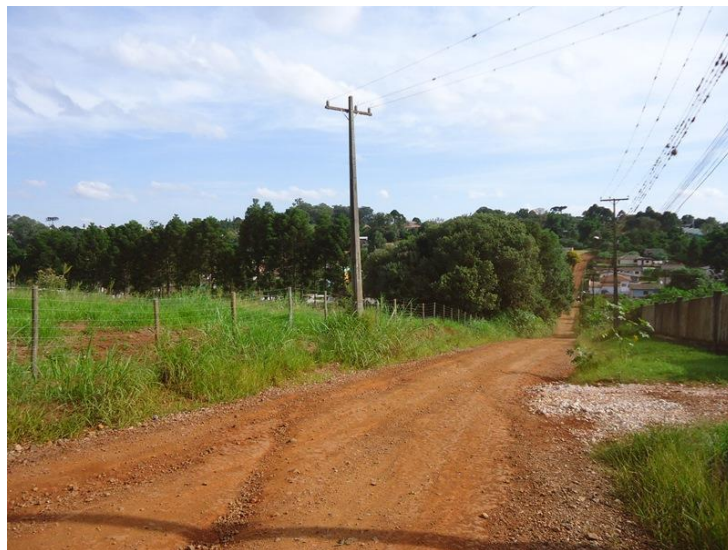
Figura 20: Rua General Barbedo, via lateral ao empreendimento.
