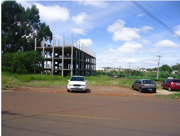
Figura 40: Terreno baldio com construção abandonada em frente ao Oficinas I.
