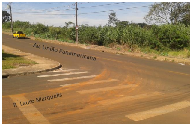
Figura 16: Interseção entre Avenida União Panamericana e Rua Lauro Marquelis.
