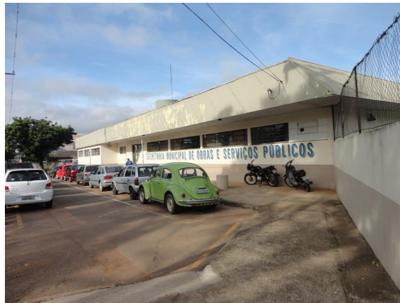
Figura 62: Secretaria Municipal de Obras e Serviços Públicos, localizada na Rua Franco Grilo.
