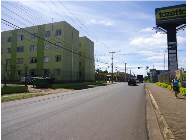
Figura 28: Rua Santa Rita Durão esquina com a Rua Franco Grilo.
