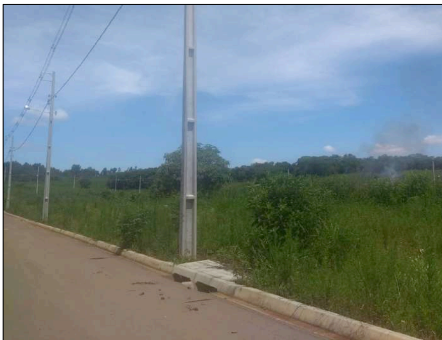
Figura 47. Boca de lobo.
