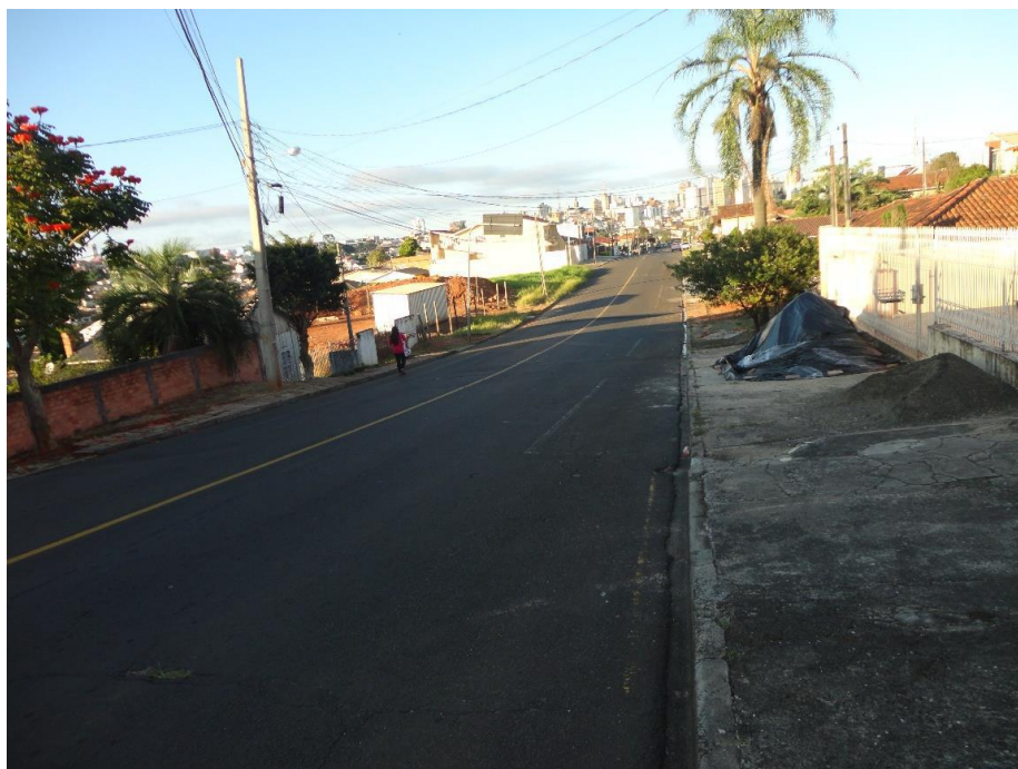
Imagem 34 - Vista da Rua Evaristo da Veiga sentido centro
