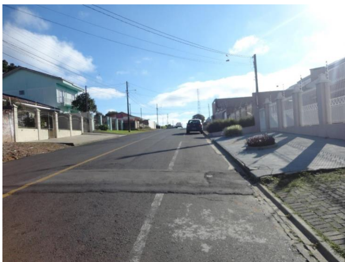
Imagem 40 - Marcação no asfalto da faixa de rolamento e estacionamento.
