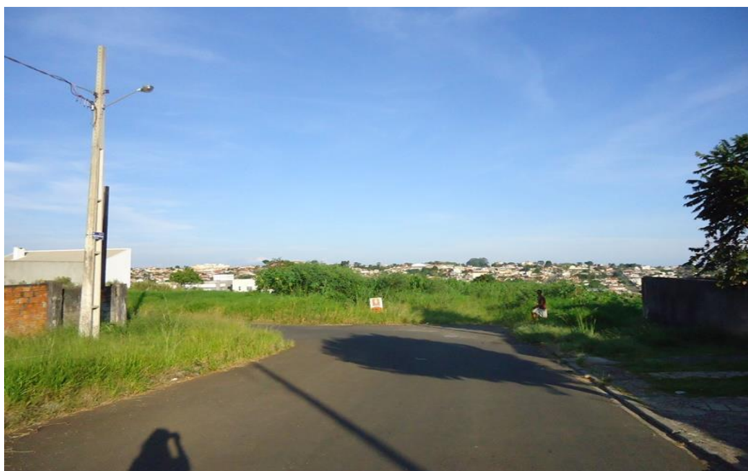
Imagem 2 - Vista para o local onde será construído o Condomínio Residencial Jardim Carvalho.
