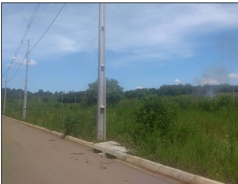
Figura 46. Boca de lobo.
