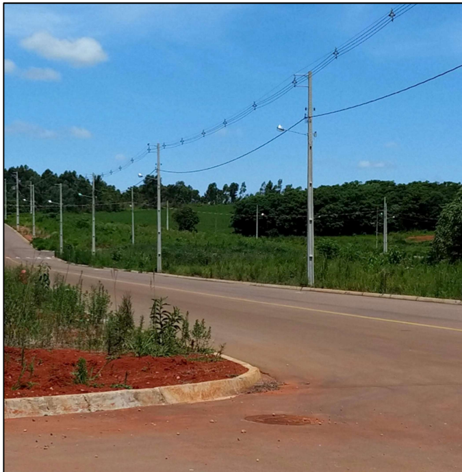
Figura 45. Poço de visita da SANEPAR.
