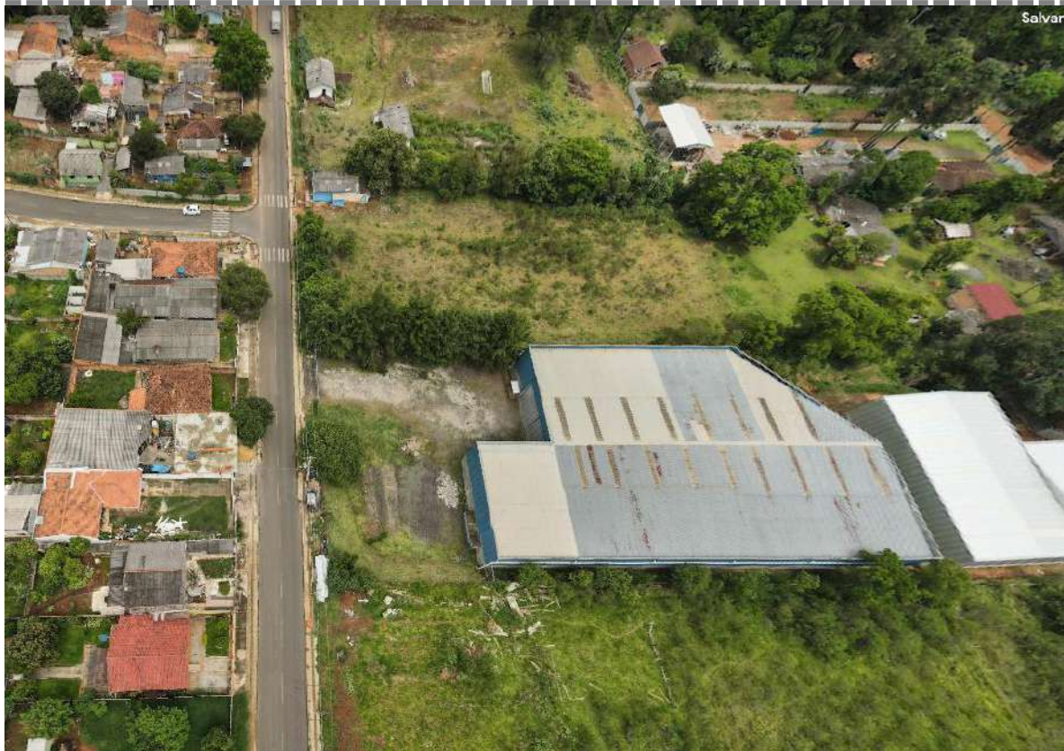
Figura 105: Vista aérea da via Cirema Becker, de acesso ao empreendimento. Autor: ORBIENGE, 2022.
