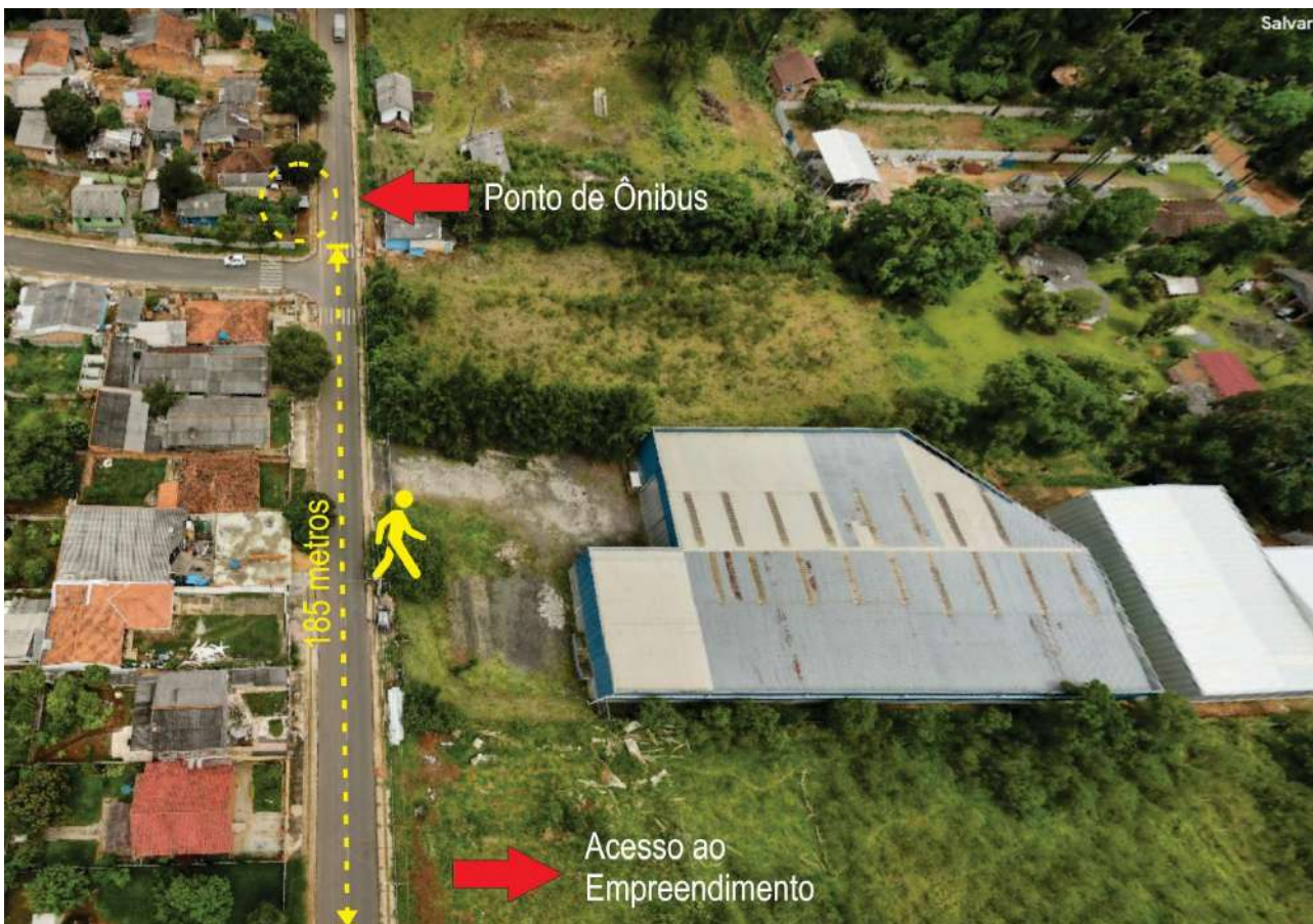
Figura 98: Vista aérea do ponto de ônibus a 185 metros da portaria do empreendimento na Rua Cirema Becker. Autor: ORBIENGE, 2023.
