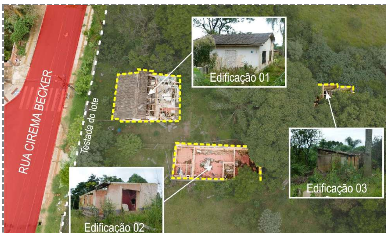
Figura 2: Edificações existentes. Autor: ORBIENGE, 2022.
