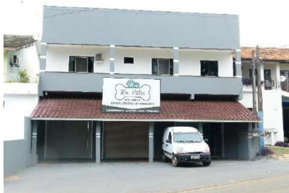
Figura 40: Atividade de serviço – clínica veterinária. Autor: ORBIENGE, 2023.
