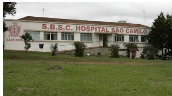
Figura 59: Hospital São Camilo.
