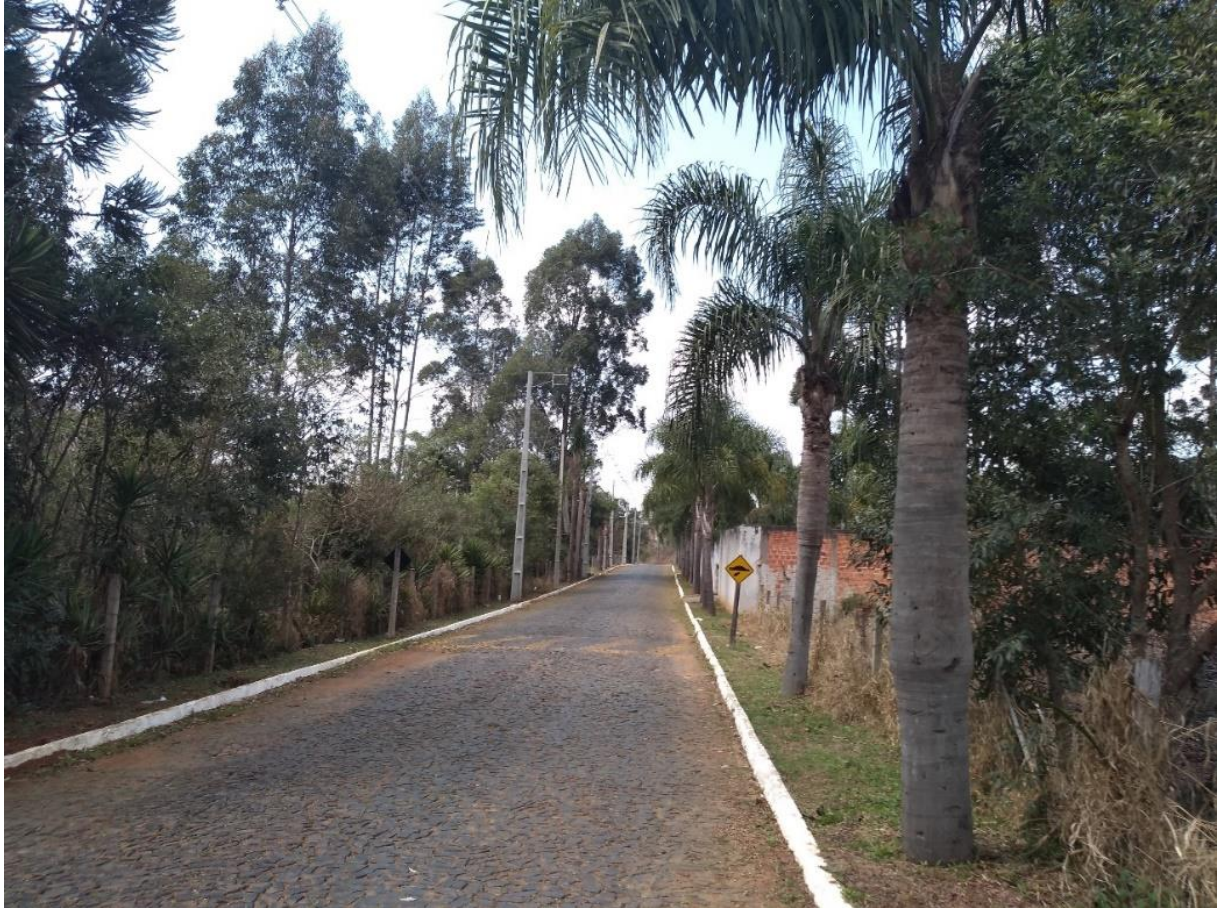
Figura 67: Situação da Rua João Henrique Van Wilpe que dá acesso ao empreendimento.
