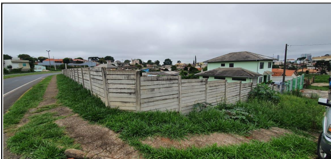
Imagem 04: Visão geral da área de instalação do edifício.
